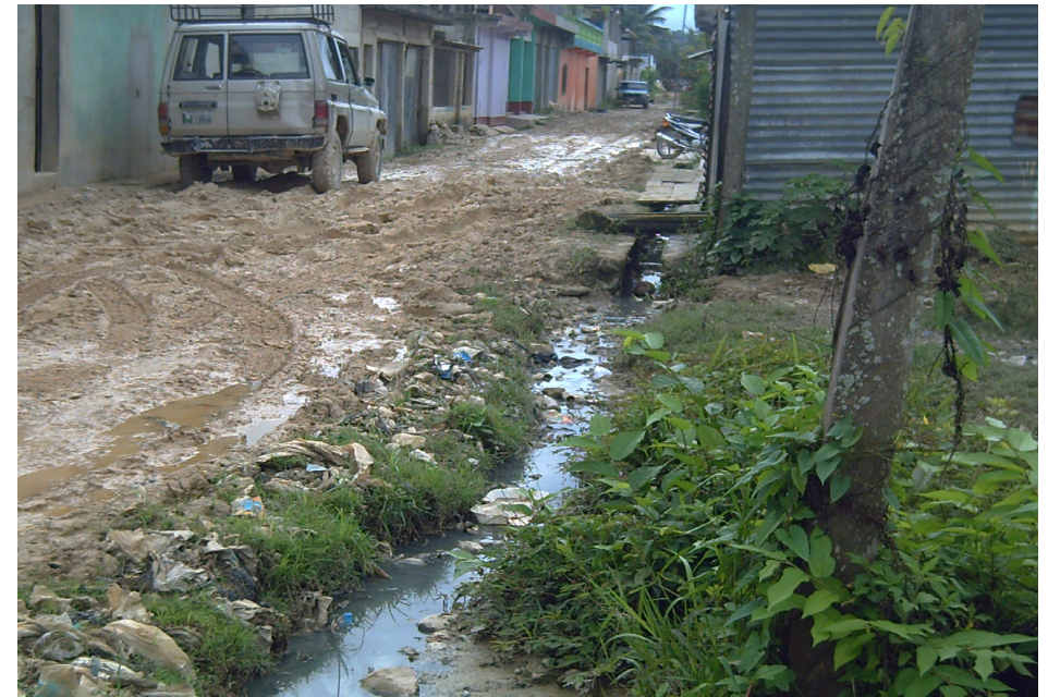
FOTO No. 4 Drenajes pluviales en Melchor de Mencos.
