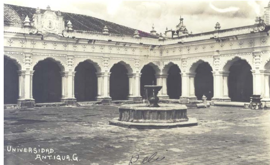
Fotografía 4.2: Patio Central de la Universidad de San Carlos de Guatemala. Antigua Guatemala, 1890. Fuente: Monterroso, Karla. Propuesta de Restauración y Reciclaje del Edificio de la Antigua Universidad de San Carlos en el Valle de Panchoy. Tesis de Licenciatura, Facultad de Arquitectura. USAC. Guatemala.
