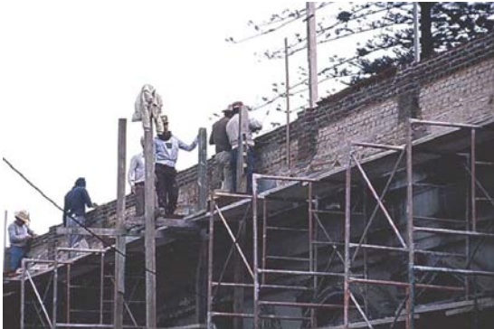
Fotografía 4.49 Reparación de Cornisa en fachadas exteriores. Fuente: Archivo Fotográfico Arq. Erwin Guerrero.
