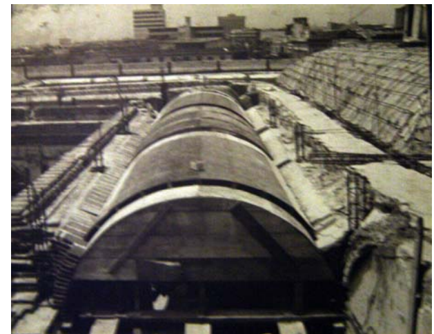
Fotografía 4.19: Armadura para bóvedas de cañón. Fuente: Archivo MUSAC
