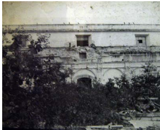
Fotografía 4.13: Arcada del corredor oriente totalmente derruida Fuente: Archivo MUSAC.
