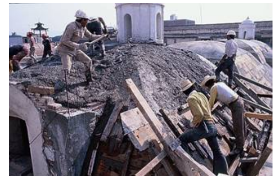
Fotografía 4.39 Trabajos de Fundición. Fuente: Archivo Fotográfico Arq. Erwin Guerrero.
