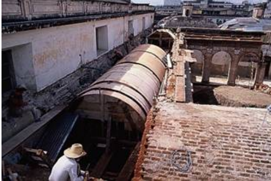
Fotografía 4.34 Formaletas de Bóvedas de cañón. Fuente: Archivo Fotográfico Arq. Erwin Guerrero.
