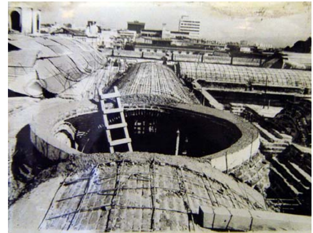
Fotografía 4.19: Armadura para bóvedas de cañón. Fuente: Archivo MUSAC
