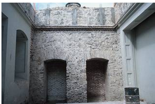
Fotografía 4.31 Servicios sanitarios terminados. Fuente: Archivo Fotográfico Arq. Erwin Guerrero.
