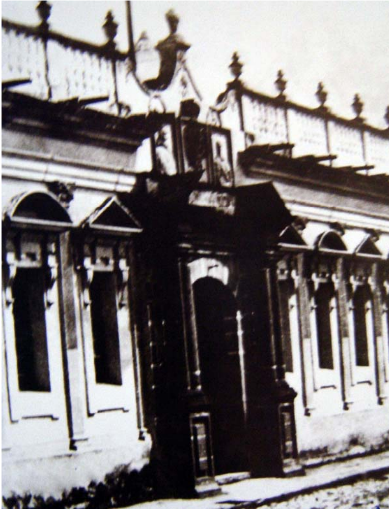
Fotografía 4.20: Fachada del Edificio Universitario antes del terremoto de 1917-18, en la que se puede apreciar el falso balaustre y las gárgolas que se retomaron para esta intervención. Fuente: Archivo MUSAC.
