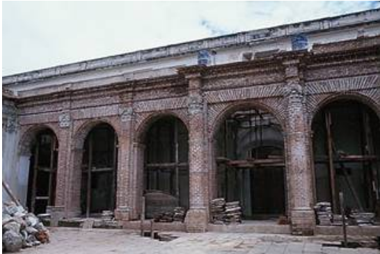
Fotografía 4.46 Levantamiento de arquería en mampostería. Fuente: Archivo Fotográfico Arq. Erwin Guerrero.
