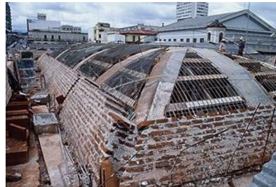
Fotografía 4.44 Reconstrucción de bóveda ojival. Fuente: Archivo Fotográfico Arq. Erwin Guerrero.
