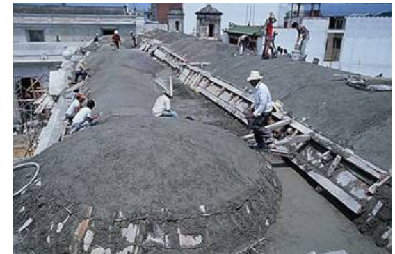
Fotografía 4.45 Fundición en el área de la bóveda ojival. Fuente: Archivo Fotográfico Arq. Erwin Guerrero.
