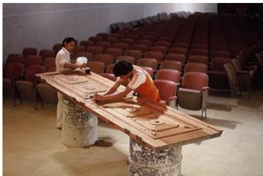
Fotografía 4.28: Reparación de Puertas. Fuente: Archivo Fotográfico Arq. Erwin Guerrero.
