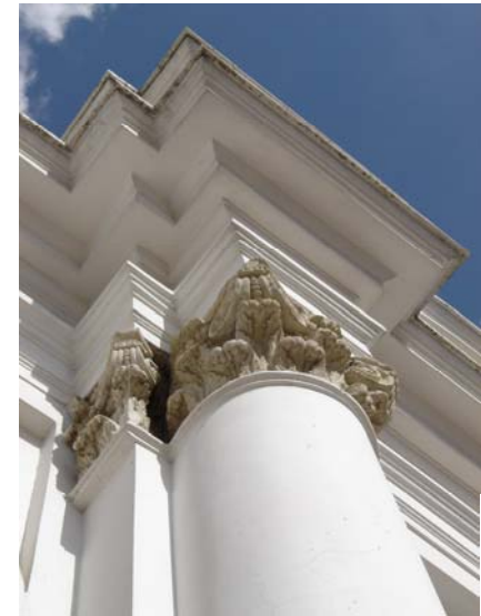
Fotografía 1.3: Detalle del estilo arquitectónico Neoclásico que predomina en el edificio. Fotógrafo: Werner A. Solórzano Orellana.
