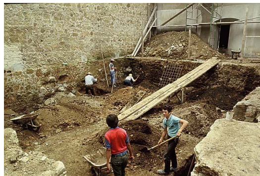
Fotografía 4.32 excavación para Construir Bodegas y talleres. Fuente: Archivo Fotoaráfico Ara. Erwin Guerrero.
