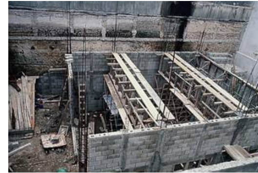
Fotografía 4.33 Levantamiento de Área de Bodegas. Fuente: Archivo Fotográfico Arq. Erwin Guerrero.
