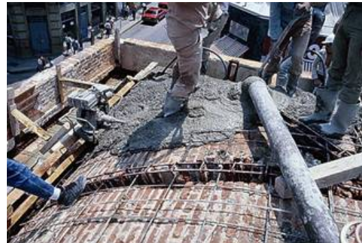
Fotografía 4.38 Cada cierta Distancia se crearon cinchos de amarre en la bóveda de cañón corrido. Fuente: Archivo Fotográfico Arq. Erwin Guerrero.
