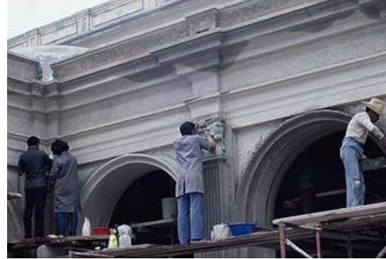
Fotografía 4.47 Fase de acabados y restauración. Fuente: Archivo Fotográfico Arq. Erwin Guerrero.
