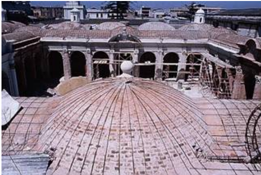
Fotografía 4.37 Después de armar la losa con mampostería se colocó electromalla para luego fundir todo el techo para unificarlo. Fuente: Archivo Fotográfico Arq. Erwin Guerrero.
