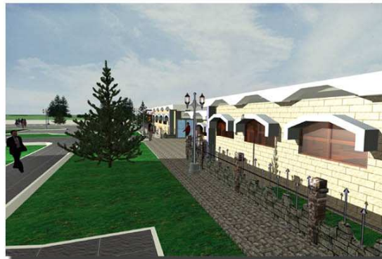
Vista Lateral de Salón de Usos Múltiples
