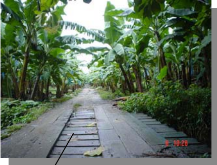
Puentes de madera sobre canales de riego hacia bananales
