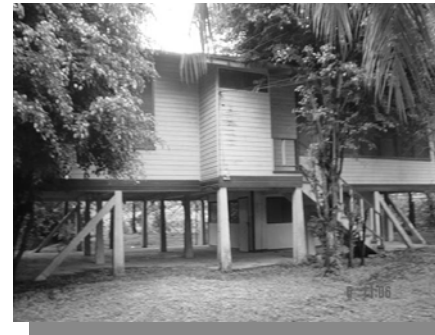
Foto No. 50. Vivienda unifamiliar para personal de alto rango en Finca El Pilar. Distrito Motagua. Se encuentra desocupada. Fuente: Elaboración propia, visita de campo.
