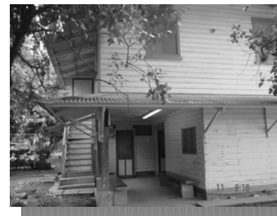
Foto No. 62. Dispensario en edificio de madera encontrado en Finca La Primavera. Fuente: Elaboración propia, visita de campo.
