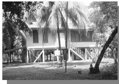
Foto No. 6 Vivienda Unifamiliar en Finca El Pilar, Los Amates, Izabal
