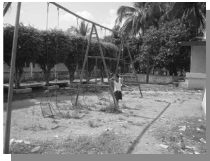
Foto No. 63. Parque infantil, en finca La Primavera, Distrito de Bobos. Un niño tratando de jugar con los columpios deteriorados.
