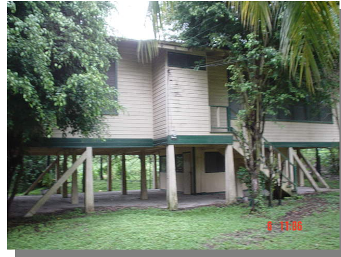
Foto No. 66 Vivienda de madera Tipo A, unifamiliar en Finca el Pilar Fuente: Elaboración propia, visita de campo
