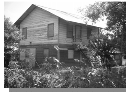
Foto No. 46. Vivienda de madera unifamiliar de bajo rango encontrada en Finca Primavera. Distrito de Bobos. Fuente: Elaboración propia, visita de campo.
