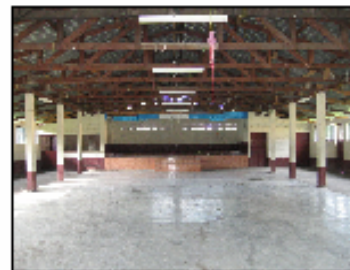
FOTOGRAFIA 2 Como lo muestra en la fotografía, la estructura es de madera, con láminas mallas calibre 24, en el interior se observa una serie de columnas para el soporte de dicha estructura.
