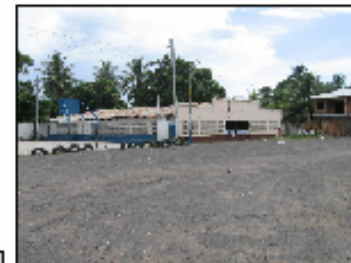
FOTOGRAFIA 3 El salón comunal no tiene ningún nivel, localizado en una planicie total, esto ha traído como consecuencia inundaciones en calles tanto alrededor e esta como en el interior del edificio.
