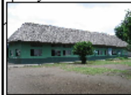
FOTOGRAFIA 4 El edificio No. 1 consta de 7 aulas, todas ellas con la infraestructura necesaria, ventilación e iluminación suficiente para la cantidad de personas que utilizan estas instalaciones. El material para la estructura del techo es de madera con palma, característico del lugar.
