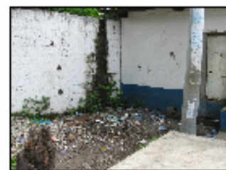
FOTOGRAFIA 6 En los extremos del edificio se observó que se hicieron algunos cambios, por ejemplo la abertura de una puerta, la humedad de las paredes se localizan específicamente en las orillas del edificio.
