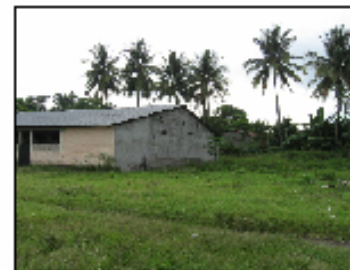
FOTOGRAFIA 4 El salón municipal cuenta con suficiente terreno para ampliación, en general el salón se encuentra en buenas condiciones y su funcionalidad es buena ya que cuenta con tres entradas y salidas como lo muestra en la planta arquitectónica.
