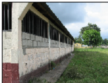
FOTOGRAFIA 1 El salón Municipal cuenta con una simetría igual en ambos lados, su cerramiento es por medio de balcones fundidos para la seguridad del mismo.
