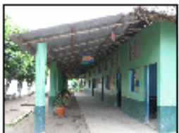
FOTOGRAFIA 5 Los comedores fueron implementados con sombra de material de lámina metálica, la ventilación, puertas e instalaciones se encuentran en buen estado, esto debido al buen mantenimiento de la institución.
