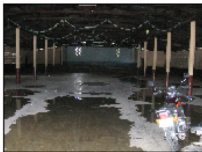
FOTOGRAFIA 5, 7 Se claro que la filtración del agua es bastante, principalmente en la entrada del edificio, en los extremos las ventanas son de celosía, esto trae como consecuencia la falta de iluminación y ventilación.
