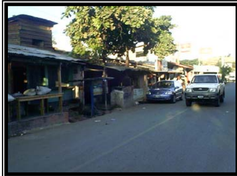
FOTO No. 6 ESTAS CIAMPAS SE ENCUENTRAN UBICADAS EN EL CALLEJÓN HACIA COBAN REDUCIENDO EL PASO VEHICULAR; DEBIDO A ESO LOS BUSES NO TIENEN PASO YA QUE NO CUENTAN CON UN AREA DE PARQUEO O ESTACIONAMIENTO LOS AUTOMOVILES, REDUCIENDO LA CALLE A UN SOLO CARRIL.
