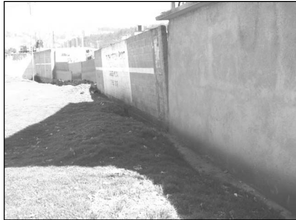
2.6.9-F7 TERRENO VISTA 1
