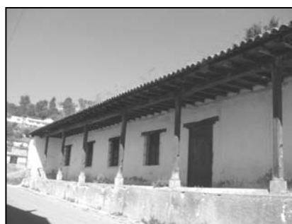
2.6.9-F2 6ta. CALLE ZONA 4 En la fotografía se muestra la fachada lateral del convento sobre la 6ta. Calle.
