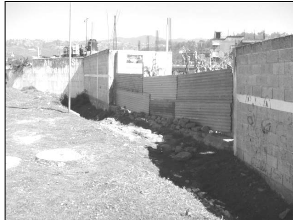
2.6.9-F8 TERRENO VISTA 2
