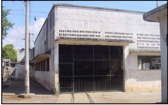
APUNTE INGRESO - ESTRUCTURA EXISTENTE -
