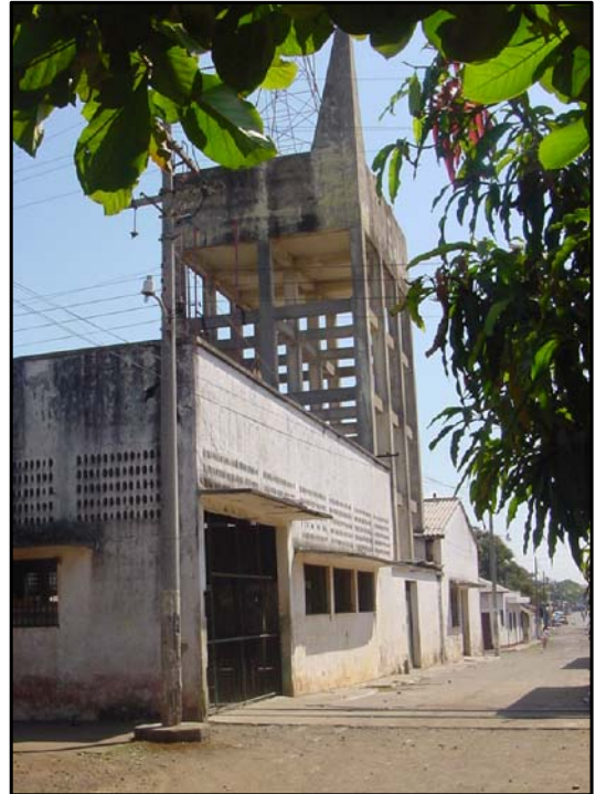
APUNTE INGRESO - ESTRUCTURA EXISTENTE -
