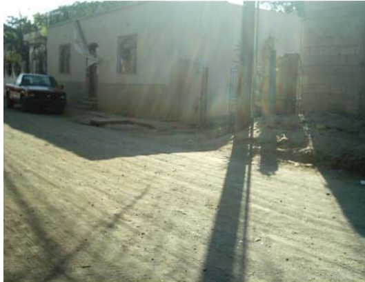
VISTA DE LA CARRETERA PRINCIPAL DE CANALITOS
