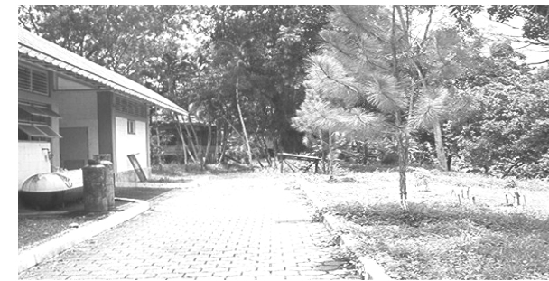
Foto No. 86: Vista de la calle que conduce al terreno propuesto, nótese que adjunto a este se encuentran las instalaciones del INDAPS, y al fondo se encuentran las edificaciones que se reciclarán.
