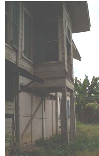
Fachada principal Sureste Fotografía No. 78
