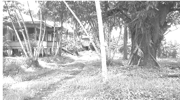
Foto No. 89: Obsérvese que el terreno no es utilizado para ningún beneficio y no cuenta con mantenimiento alguno, al fondo se observan las edificaciones a reciclar, los cuales se integrarán al proyecto propuesto.
