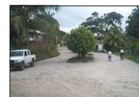
FOTOGRAFIA No. 17 FINAL CALLE PRINCIPAL
