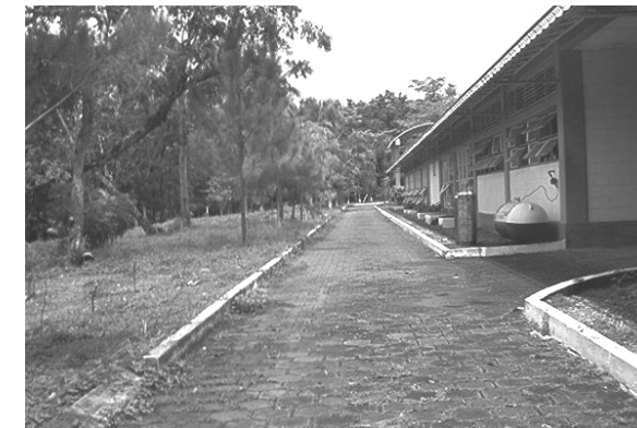
Foto No. 39 – Vista lateral sur del nuevo edificio del salón de actos y comedor.
