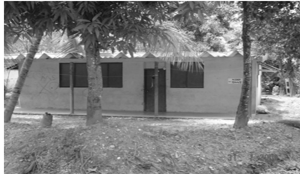
Foto No. 5 – Construcciones a base de muros de block y techos de lámina de duralita, Finca Pueblo Nuevo, Distrito del Motagua, Los Amates, Izabal)
