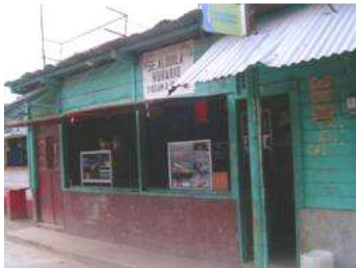
FOTO No. 35 Casetas que se han construido sobre propiedad de FEGUA.
