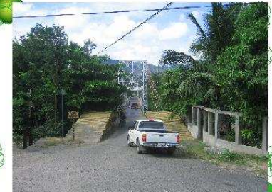
Vista No. 3 ingreso a la calle principal donde se encuentra ubicado el terreno
