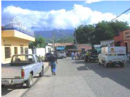
FOTO No. 30. Los puestos del mercado se colocan sobre la calle, impidiendo la circulación por las mismas. En la foto se observa un día en que no se colocaron los puestos.
