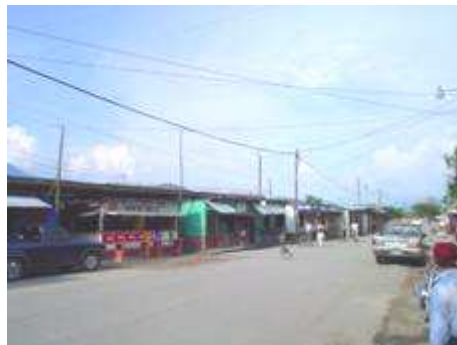
FOTO No. 24 casetas construidas en la bodega de FEGUA.
