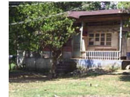
FOTO 13 EDIFICACIONES DE LA EPOCA (Leslie Marroquín)
