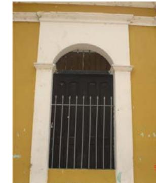
**Fotografía 79.** Detalle de típico de las ventanas del instituto en el exterior. Se aprecia el uso del arco y de las columnas laterales. **Fuente:** propia.
