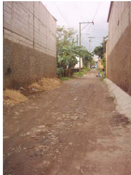
Foto 1. 3ª calle y 3ª avenida A, es una de las típicas calles de la zona 2, es decir, angostas sin asfalto u otro tipo de recubrimiento y en su mayoría sin área de banqueta.
