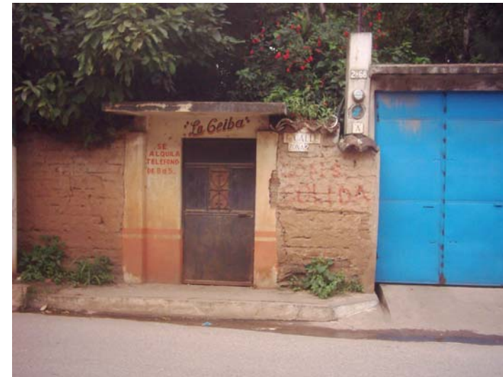
Fotografía No. 7 Tipología de viviendas en la zona 2 del Municipio de Villa Nueva. (01 calle y 01 avenida zona 2.)
