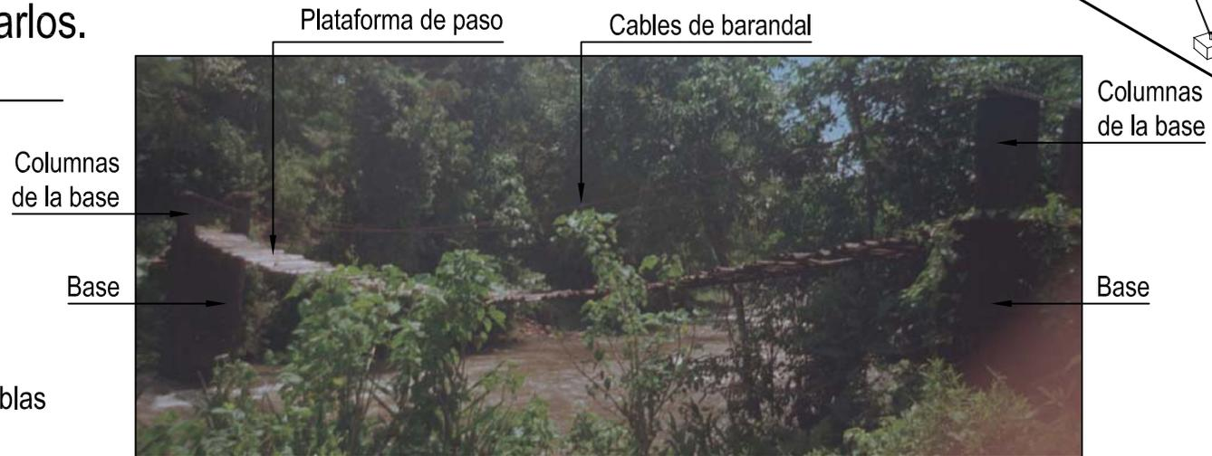
Fotografía de la estructura total del puente.
