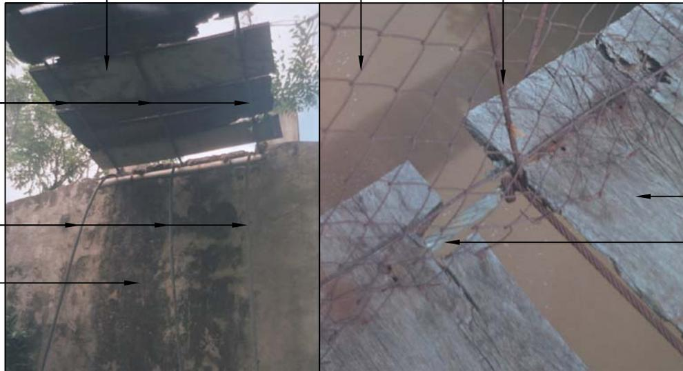
Fotografía de la parte inferior de la base en donde se aprecian los cables rotos.
