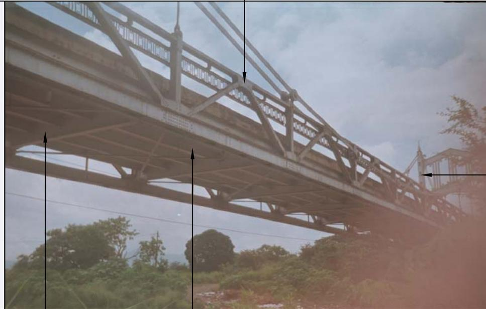
Vigas transversales    Vigas longitudinales
