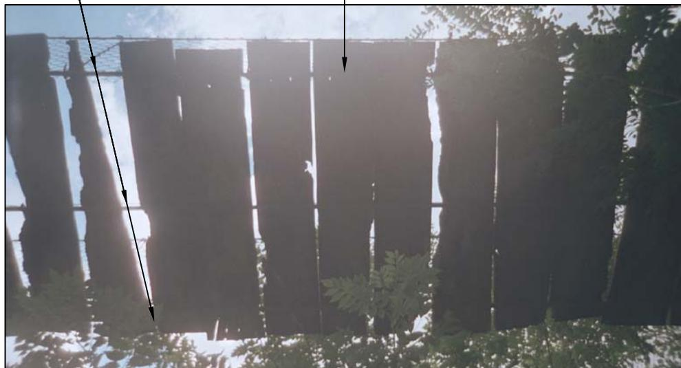
Fotografía de la parte inferior de la plataforma de paso del puente, de donde se aprecia el avanzado nivel de deterioro de la estructura del puente.
