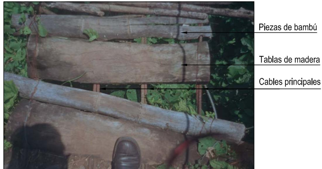
Fotografía de las deterioradas tablas de madera y las piezas de bambú de la plataforma de paso.
