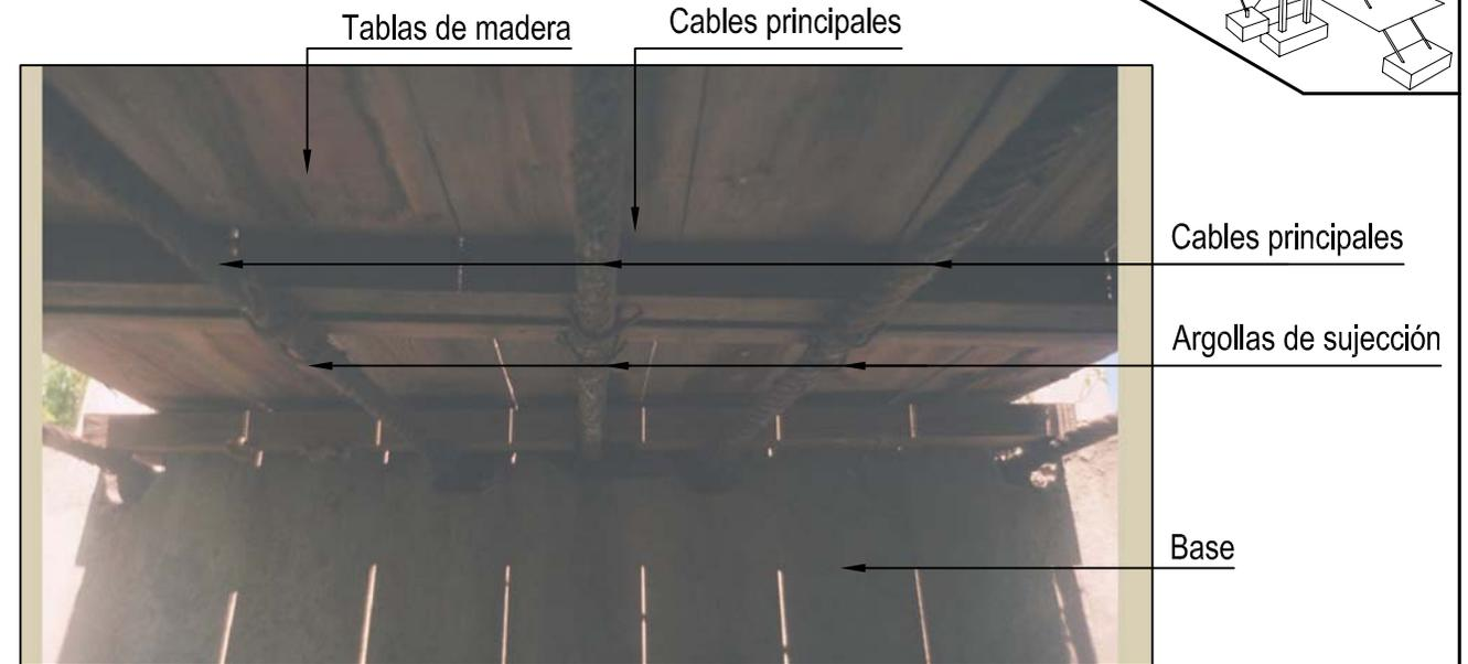
Fotografía de la unión de la parte inferior de la rampa de ingreso con la base del puente, en la que se observa la disposición de los cables principales y sus accesorios.
