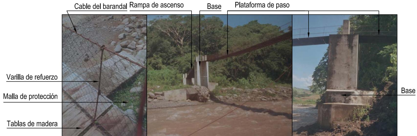
Fotografía del detalle del barandal de la plataforma de paso.
