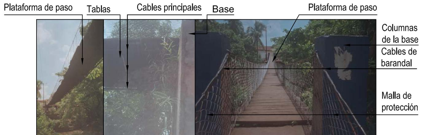
Foto izquierda: plataforma de paso del puente.
