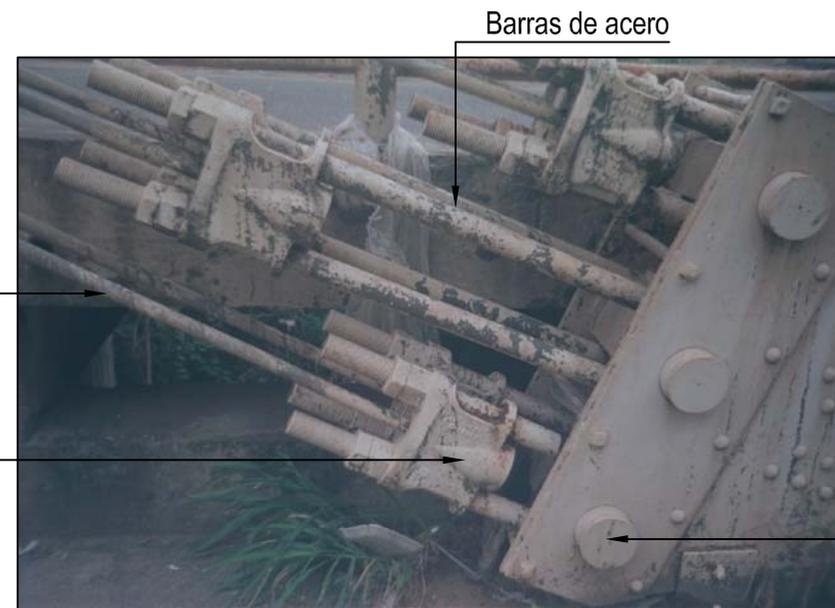
Fotografía de la platina de unión entre los cables y el anclaje principal.
