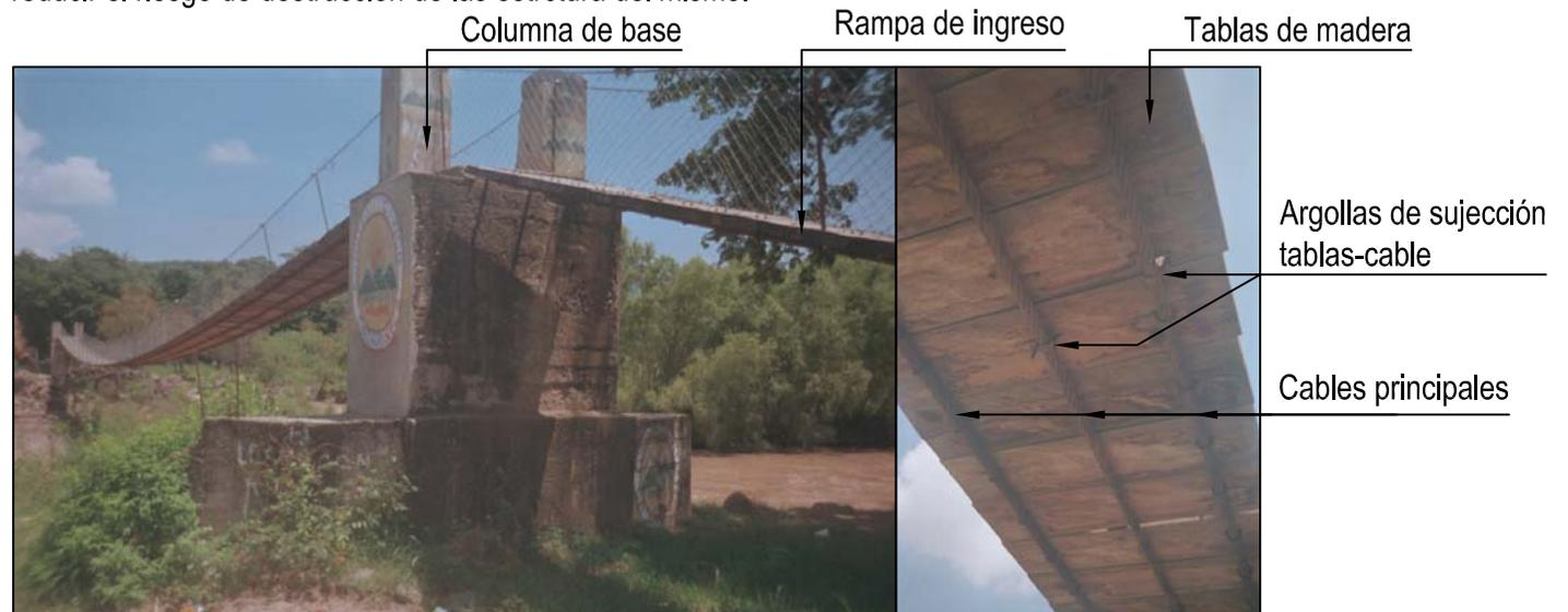
Fotografía de la base oeste del puente, en la que se observa la rampa de ascenso a la base y la plataforma de paso.
