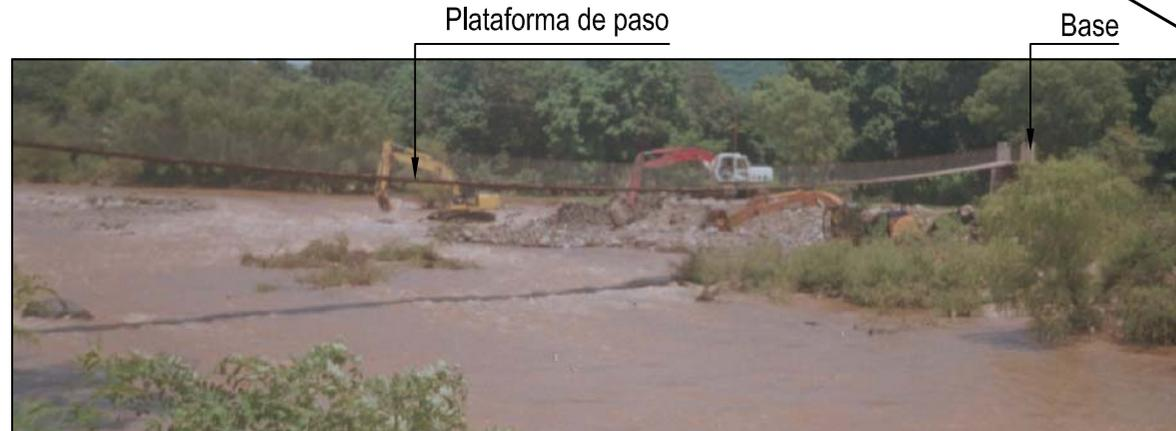
Fotografía de la parte este del puente, en donde se aprecia los trabajos de dragado de las orillas del río Ostúa, para reducir el riesgo de destrucción de las estructura del mismo.
