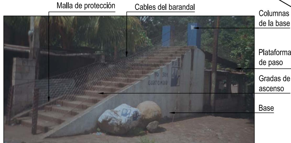
Fotografía de la escalinata de ascenso hacia la base y plataforma de paso del puente.
