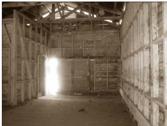
Interior area de espera (Ilustracion 84) Foto: Pamela Cifuentes
