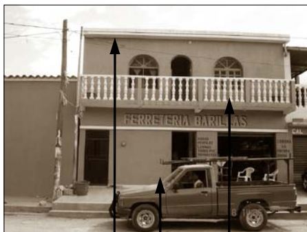
(Ilustración 39) CENEFAS Y LOSAS BARANDAS MUROS DE BLOCK
