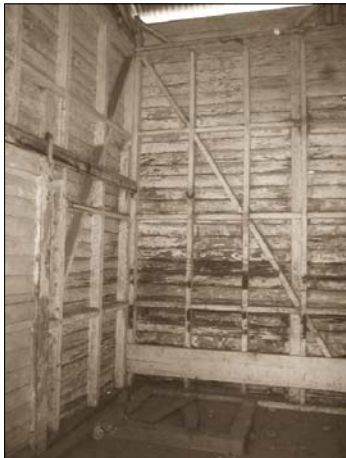
Interior area de espera (Ilustracion 81) Foto: Pamela Cifuentes
