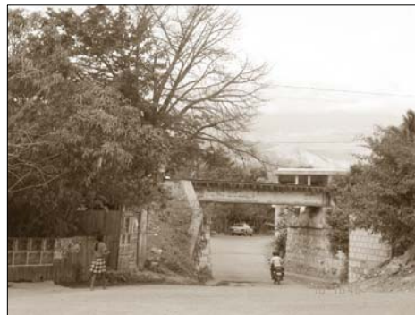
5 (Ilustración 52) AREA DONDE SE UBICA UN PUEBLO EN LA LINEA FERREA, ESTA AREA ES EL INGRESO PRINCIPAL AL CASCO URBANO DE EL JICARO
