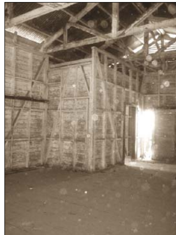
Interior area de espera (Ilustracion 82) Foto: Pamela Cifuentes
