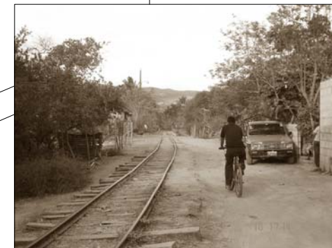
12 (Ilustración 56) TRAMO DENTRO DEL BARRIO DE VISTA BELLA, SIN MANTENIMIENTO, NO EN MAL ESTADO, CON POCO DERECHO DE VIA
