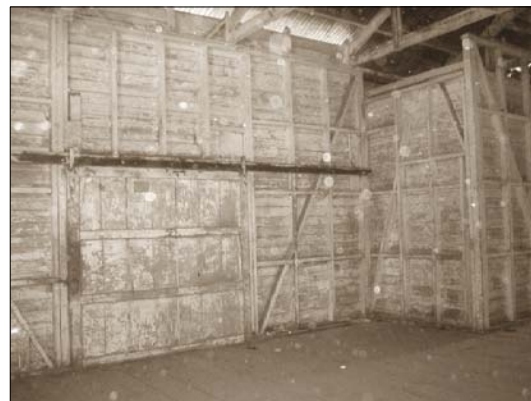
Interior area de espera (Ilustracion 85) Foto: Pamela Cifuentes
