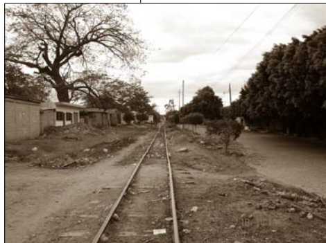
7 (Ilustración 53) ESTE TRAMO ES EL MAS CERCANO A LA ESTACION DEL FERROCARRIL, SE ENCUENTRA SIN MANTENIMIENTO Y ACUMULACION DE BASURA Y CON FALTANTE DE DÜRMIENTES
