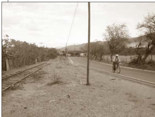
1 INICIO DE LINEA FERREA EN EL TRAMO DE VIA DEL CASCO URBANO EN BUEN ESTADO. (Ilustración 57)
