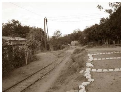
11 (Ilustración 61) TRAMO DONDE SE UBICA LA CUCHILLA QUE DIVIDE LA LINEA FERREA QUE SE DIRIGUE AL BARRIO VISTA BELLA DE LA CALLE PRINCIPAL, EN ESTADO REGULAR CON UN POCO DE MANTENIMIENTO
