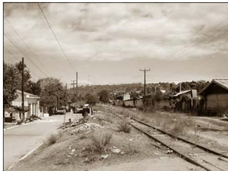
8 (Ilustración 54) ESTE TRAMO ES EL MAS CERCANO A LA ESTACION DEL FERROCARRIL, SE ENCUENTRA SIN MANTENIMIENTO Y ACUMULACION DE BASURA
