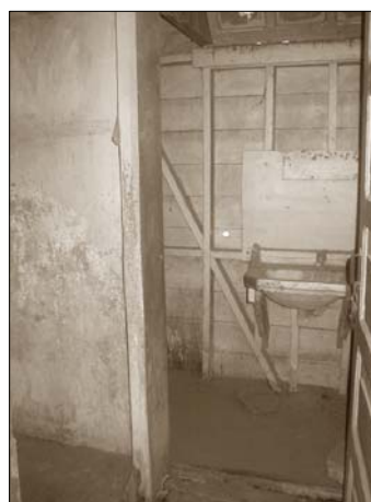
Interior servicio sanitario (Ilustracion 72) Foto: Pamela Cifuentes
