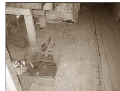
Interior area de pila (Ilustracion 69) Foto: Pamela Cifuentes
