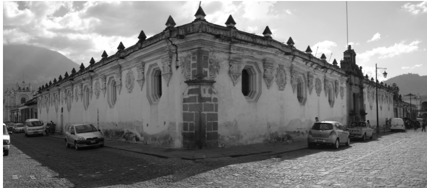
Gráfica 3: Fachada Actual. Se observan las ventanas octogonales que sustituyeron a las puertas.
