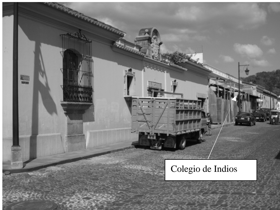
GRÁFICA 20: 4ta. Calle Oriente, donde se encuentra el Colegio de Indios de Guadalupe. Se muestra el mal estado del empedrado.
