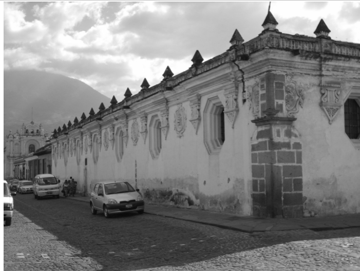
Gráfica 8: Fachada lateral actual. Se observan las ventanas octogonales hechas después de 1950
