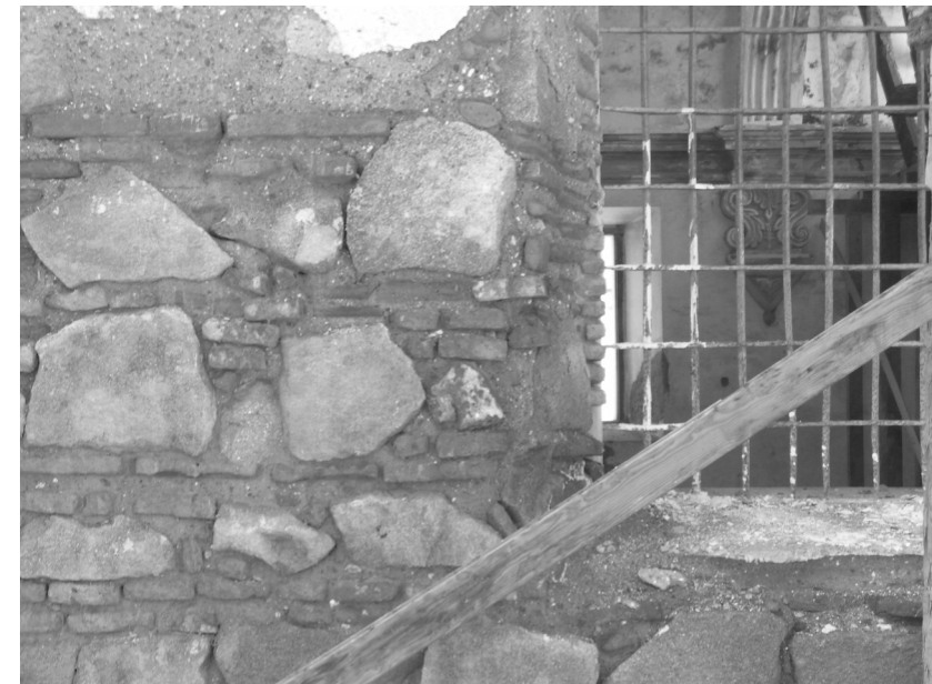
Gráfica 1: Muro de calicanto. Se pueden observar las hileras de ladrillo e hileras de piedra.
