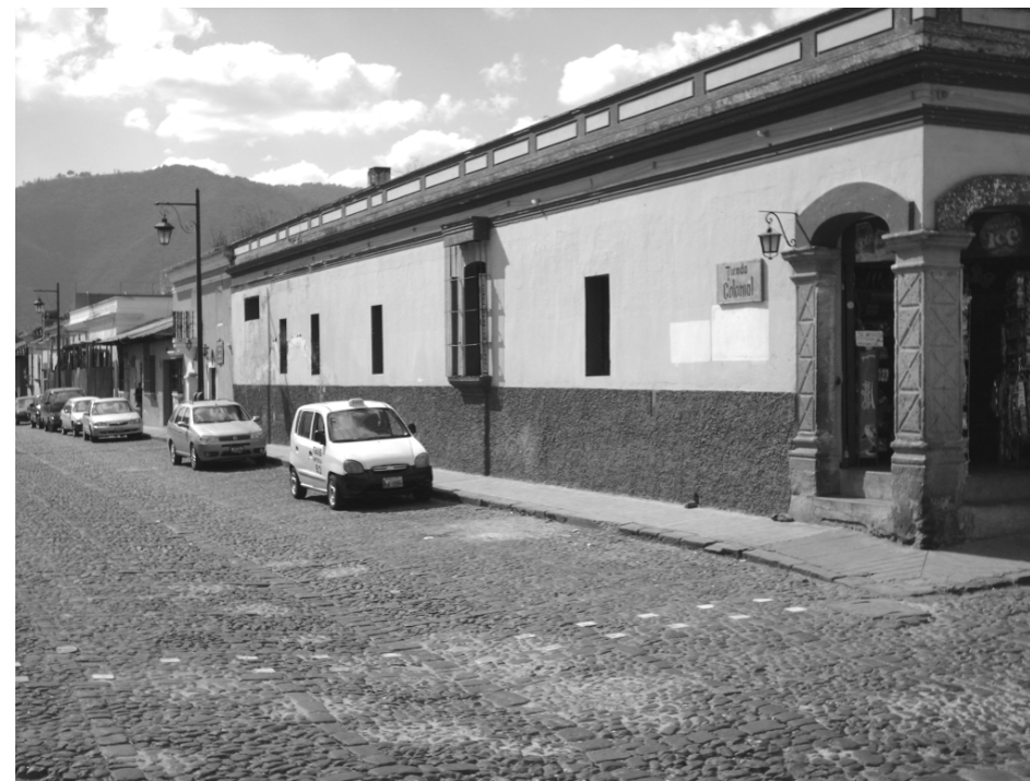
GRÁFICA 21: 4ta. Calle Oriente, en donde la instalación eléctrica es subterránea.
