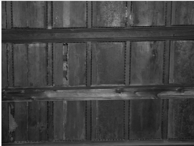
Gráfica 36: Deterioro de artesanado sala No.7, por causas de insectos y humedad
