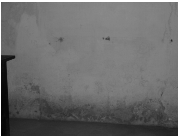
Gráfica 44: Manchas de humedad por capilaridad. Interior sala Villalpardo
