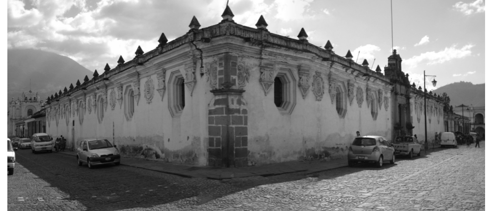
GRÁFICA 14: PERSPECTIVA 2006, se muestra la fachada actual del edificio
