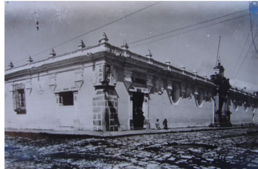
Gráfica 2: Fachada Original. Se observan las puertas en esquinas y las ventanas en la fachada lateral que actualmente son octogonales. Fuente: Museo de Arte Colonial. Autor anónimo.
