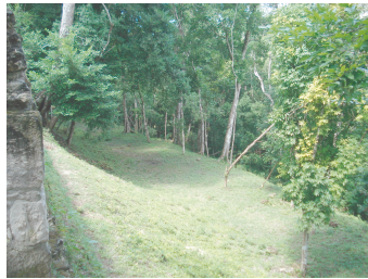
FOTO 1 Muro de Contención.
