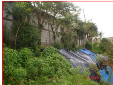
FOTOGRAFÍA 2 Talud sin tratamiento, aldeño a la escuela.
