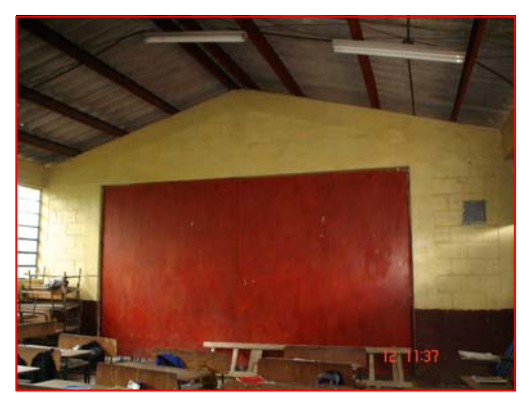
FOTOGRAFIA 4 Interior del Aula. Se observa la estructura portante del techo.
