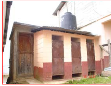
FOTOGRAFIA 1 Módulo de Letrinas de la Escuela. Depósito de agua.
