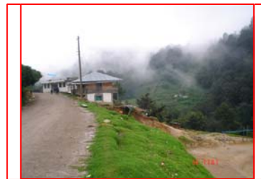
FOTOGRAFÍA 3 Viviendas ubicadas a la orilla de la carretera de acceso al Lugar Poblado, abajo se observa una cancha deportiva, la cual esta aledaña a un barranco.
