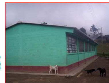
FOTOGRAFÍA 3 Muros, ventanería y estructura portante del techo en buen estado, hace falta reemplazar láminas deterioradas de la cubierta.
