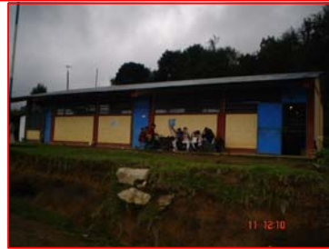
FOTOGRAFIA 2 Estudiantes de Escuela Primaria, se observa corte sin tratamiento.
