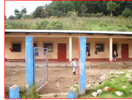
FOTOGRAFIA 3 Vista frontal de Módulo de Aulas principal.
