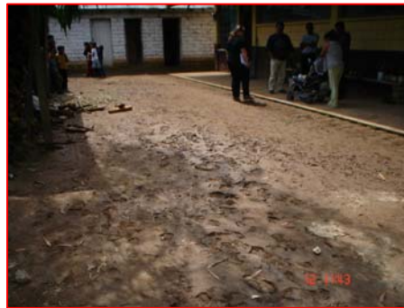
FOTOGRAFIA 2 Campo con piso de tierra, la escuela se inunda cada vez que llueve.
