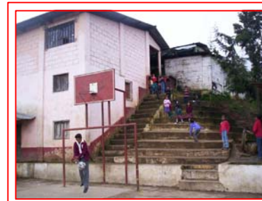
FOTOGRAFÍA 3 Gradas conjuntas a Módulo de Aulas de dos niveles.
