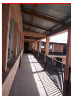
FOTOGRAFIA 3 Vista interior de pasillo en segundo nivel de módulo de aulas.
