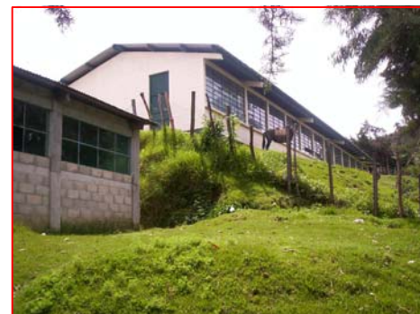
FOTOGRAFÍA 1 Vista de dos Módulos de Aulas, ubicados en el solar donde ocurrió un deslizamiento de grandes proporciones durante la Tormenta Stan en el año 2005.
