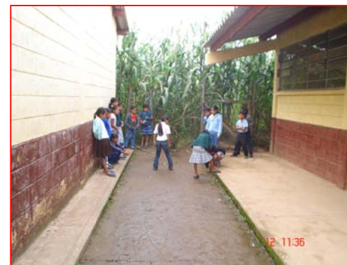
FOTOGRAFIA 4 Falta mantenimiento en pintura de muros y áreas verdes.
