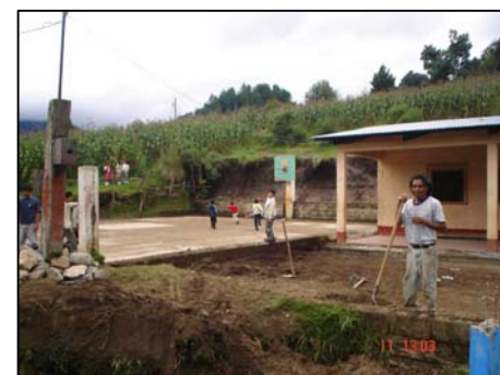
FOTOGRAFIA 2 Cancha Deportiva de la Escuela, Vecinos trabajando en el muro de contención.
