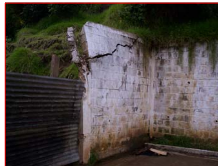
FOTOGRAFIA 5 Muro colapsado.
