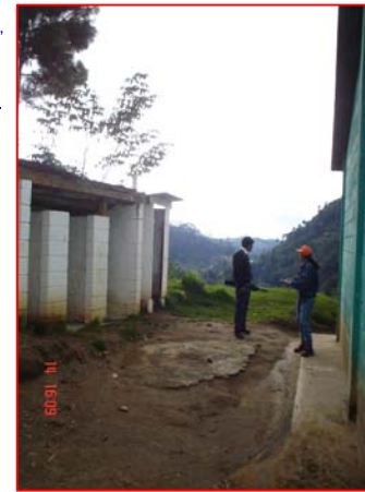
FOTOGRAFIA 2 Ingres a Escuela, se recomienda realizar muro de contención en el corte del terreno.
