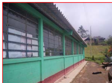
FOTOGRAFIA 4 Vista posterior de Módulo de Aulas, en buen estado.
