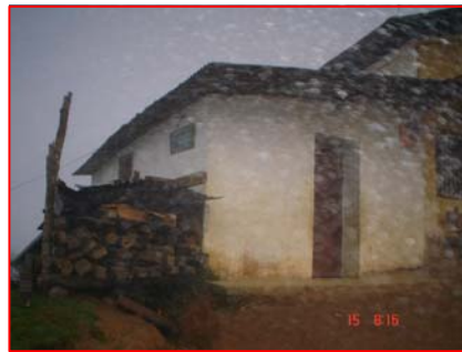
FOTOGRAFIA 5 Bodega de la Escuela.
