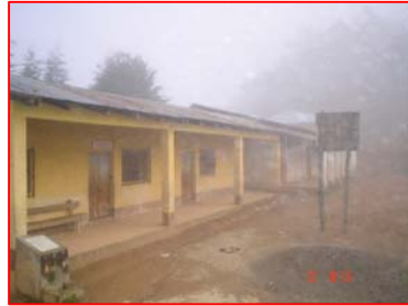
FOTOGRAFIA 2 Vista de Módulo de Aulas y Cancha Deportiva.
