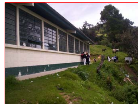
FOTOGRAFÍA 1 Deslizamiento, que pone en riesgo a la Escuela.
