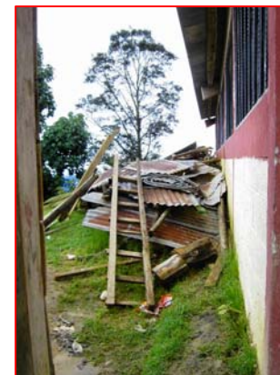
FOTOGRAFIA 3 Láminas y materiales de construcción que quedaron de una reciente reparación.
