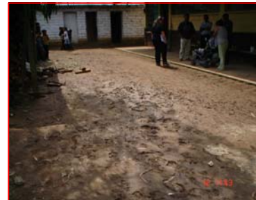
FOTOGRAFIA 1 Se observan estragos de las inundación que se produce cuando llueve.
