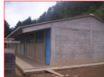
FOTOGRAFIA 2 Módulo de Aulas nuevo.
