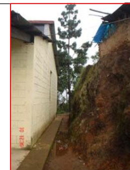
FOTOGRAFIA 6 Corte de terreno aldeaño a muro de escuela.
