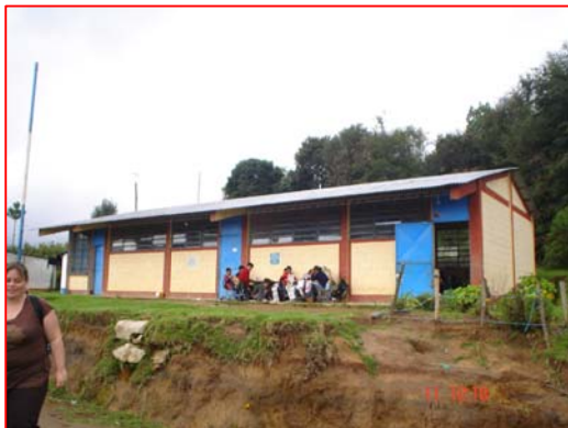
FOTOGRAFIA 4 Vista frontal de la escuela, se sugiere tratamiento al ingreso de la misma, así como al corte del terreno donde se encuentra ubicada.
