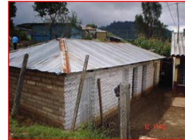
FOTOGRAFIA 1 Cocina y dormitorio de docente, construcción de adove con humedad y deterioro estructural.
