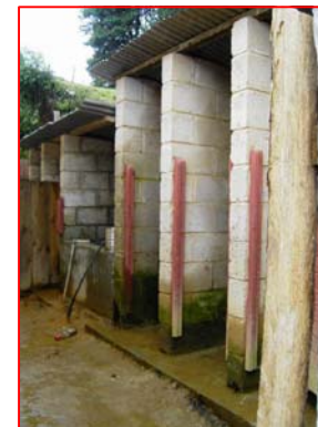
FOTOGRAFIA 2 Módulo de Aulas, se observan muros en buen estado, la estructura portante de techo es de madera y necesita reparaciones, así como la lámina de la cubierta.
