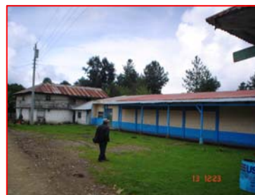
FOTOGRAFIA 5 Vista del Centro de Convergencia Comunitario y viviendas aledañas.
