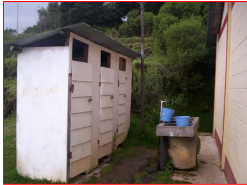
FOTOGRAFIA 1 Letrinas en buen estado, e recomienda mejorar caminamientos.
