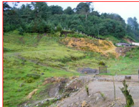
FOTOGRAFÍA 2 Vista de Escuela y Salón de Usos Múltiples destruido por un deslizamiento durante la Tormenta Stan en el 2005, cortes de terreno sin tratamiento.
