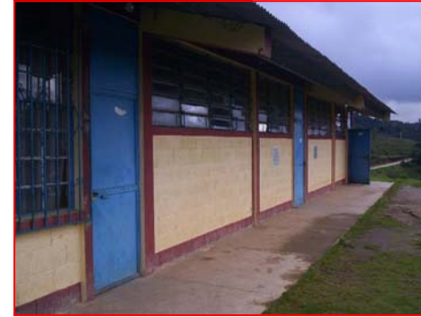
FOTOGRAFIA 3 Módulo de aulas en buen estado.
