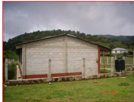
FOTOGRAFIA 5 Vista lateral del edificio escolar, se observa el block visto, en buen estado. La cubierta de lámina necesita reparaciones.
