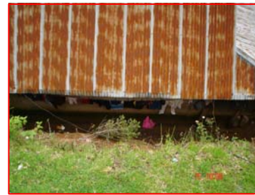
FOTOGRAFIA 2 Vista desde el frente de la Iglesia hacia la cubierta de la escuela.
