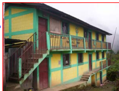
FOTOGRAFIA 5 Módulo escolar que presenta daños en la cubierta, así como humedad en cimientos, muros, balcón y módulo de gradas.
