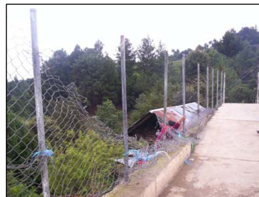
FOTOGRAFIA 3 Circulación de malla en muy mal estado, debe reemplazarse, ya que detras de esta área existe un desnivel de más de 10.00mts. Aquí se observa a un alumno tratando de subir después de ir tras el balón con el que jugaban en la cancha deportiva.
