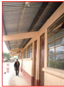
FOTOGRAFIA 2 Módulo de Aulas.
