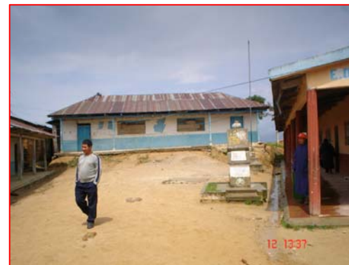
FOTOGRAFÍA 3 Escuela en desuso por deslizamiento en la parte posterior de estos edificios.
