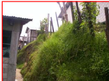
FOTOGRAFIA 2 Corte del terreno entre módulos de aulas, el cual no tiene tratamiento de contención.
