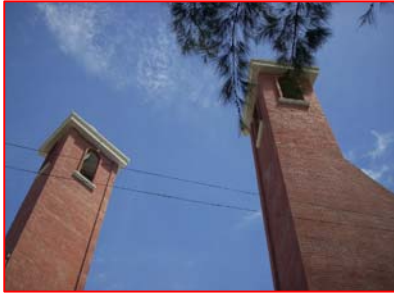
FOTOGRAFIA 1 Torres de campanarios, de ladrillo
