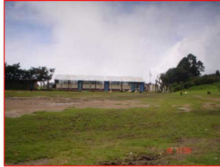
FOTOGRAFIA 2 Vista frontal del edificio escolar, el cual se ubica al lado de un campo deportivo.
