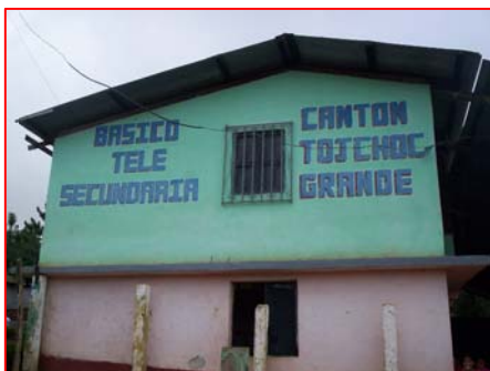
FOTOGRAFIA 4 Ingreso principal a escuela, esta área es de do niveles y en el medio tiene una plaza con piso de tierra.
