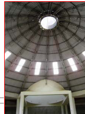
FOTOGRAFIA 2 Estructura de cúpula principal de la iglesia.
