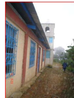
FOTOGRAFIA 3 Vista lateral de la Iglesia
