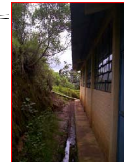
FOTOGRAFIA 3 Se observa drenaje de agua pluvial visto.
