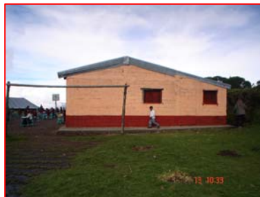
FOTOGRAFIA 4 Vista lateral de la Escuela.
