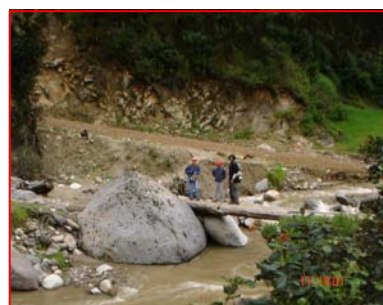
FOTOGRAFÍA 4 Puente del Río Tuismil, piedra de grandes proporciones arrastrada hasta el lugar durante la Tormenta Stan en el 2005.
