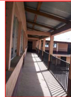
FOTOGRAFIA 1 Corredor y baranda en buen estado.
