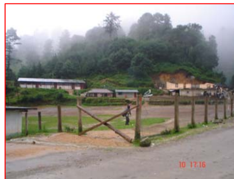
FOTOGRAFÍA 3 Vista de Cerro aledaño a Escuela y Salón de Usos Múltiples destruido por un deslizamiento durante la Tormenta Stan en el 2005, Cancha Deportiva y calle de acceso al poblado.
