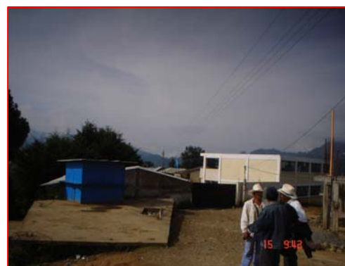
FOTOGRAFIA 6 Ingreso a Escuela la cual posee muro de circulación
