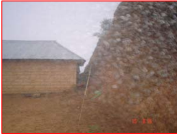
FOTOGRAFIA 1 Corte del terreno aledaño a cocina de la escuela.
