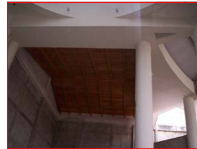
FOTOGRAFIA 1 Cielo falso de madera. Se observan muros de block con soleras y columnas de concreto reforzado.
