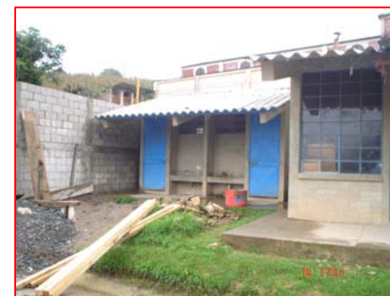
FOTOGRAFIA 6 Módulo de letrinas de reciente construcción, el cual se encuentra en buen estado.
