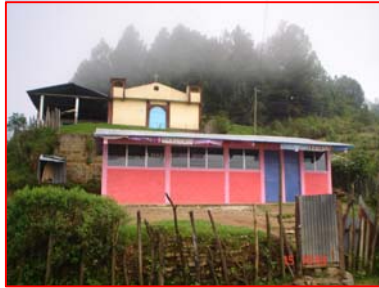
FOTOGRAFIA 1 Vista de Iglesia ubicada en un corte del terreno con diferencia de nivel de más de 3.00 mts. del lugar donde se encuentra ubicada la escuela.
