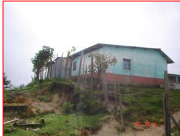
FOTOGRAFÍA 4 Las cercas que delimitan la ubicación de la alcaldía auxiliar y otras edificaciones importantes de la aldea, se encuentra en mal estado y puede provocar accidentes, se recomienda su mejora o eliminación.
