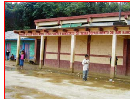
FOTOGRAFIA 1 Módulo de Aulas contiguo a Cancha Deportiva, se observa humedad en la base de los muros.
