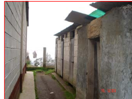
FOTOGRAFIA 2 Letrinas en buen estado, se deben mejorar los caminientos.
