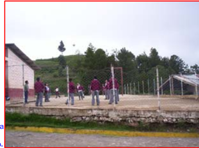
FOTOGRAFIA 2 Cancha Deportiva de la Escuela, en la parte posterior, se observa un corte del terreno, de más de 10.00 mts. de altura, sin tratamiento.
