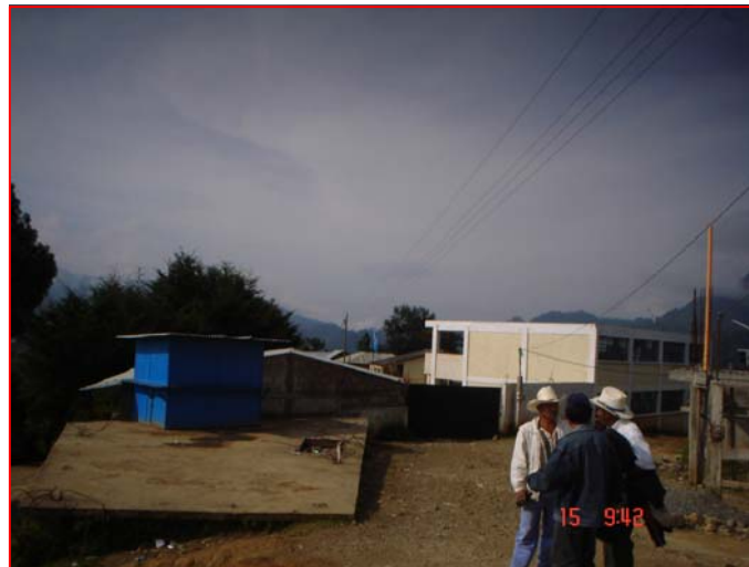
FOTOGRAFIA 2 Camino de tierra, y tienda en la entrada de la Escuela.
