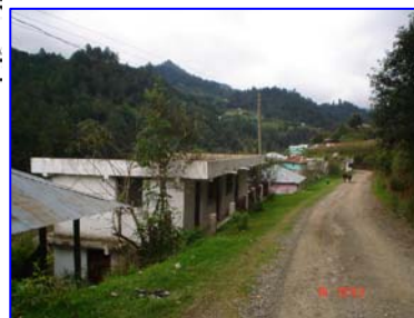
FOTOGRAFÍA 3 Calle de terracería principal del lugar poblado. Se observa ausencia de aceras o caminamientos. Lo cual constituye un riesgo para los peatones.
