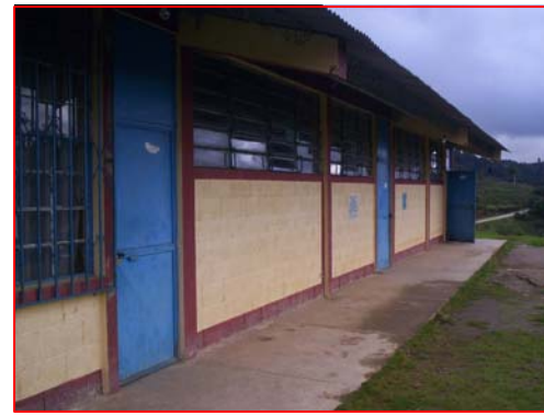
FOTOGRAFIA 2 Estructura portante de cubierta en buen estado, se deben reemplazar algunas láminas que están deterioradas. Muros, ventanas y puertas en buen estado.
