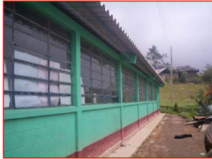
FOTOGRAFIA 1 Módulo de Aulas, en buen estado.
