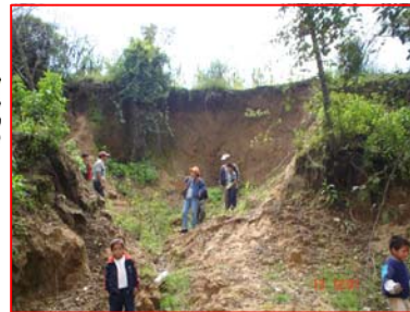
FOTOGRAFÍA 1 Deslizamiento ubicado atrás del Centro de Convergencia Comunitario.
