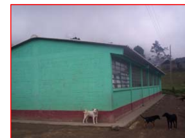
FOTOGRAFIA 6 Módulo de Aulas
