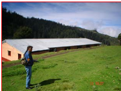
FOTOGRAFIA 1 Cubierta de láminas en buen estado.
