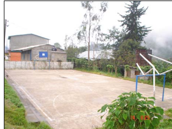
FOTOGRAFIA 1 Cancha Deportiva en buen estado.
