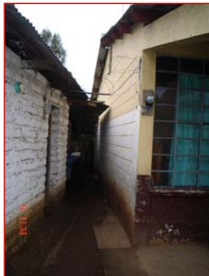
FOTOGRAFIA 1 Cocina y cuarto de dormitorio de maestro.
