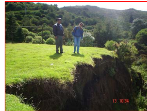
FOTOGRAFIA 2 Deslizamiento cercano a solar de la Escuela
