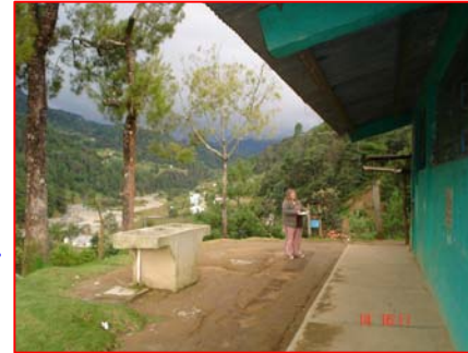
FOTOGRAFIA 2 Pila de la escuela, hace falta tratamiento en caminamientos.
