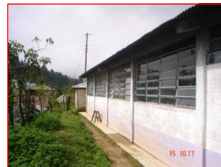
FOTOGRAFIA 1 Muro de Módulo de Aulas, en buen estado.
