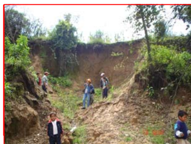
FOTOGRAFIA 4 Deslizamiento ocurrido durante la Tormenta Stan.
