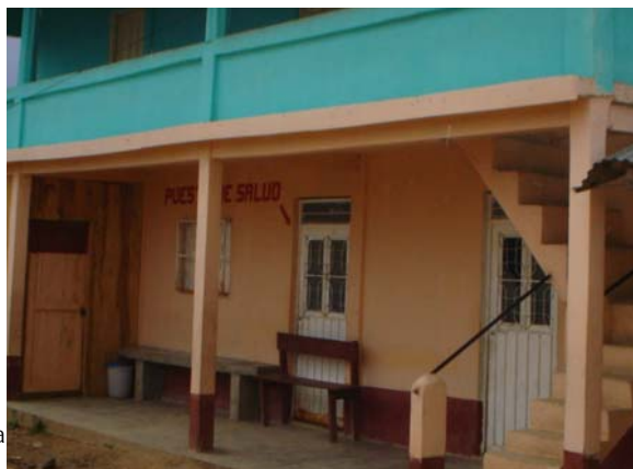
Fotografía No. 4.4 Puesto de Salud Caserío la Esperanza
