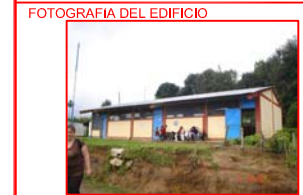
FOTOGRAFIA 2 Estructura portante de cubierta en buen estado, se deben reemplazar algunas láminas que están deterioradas. Muros, ventanas y puertas en buen estado.
