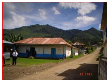
FOTOGRAFIA 1 Vista de Centro de Convergencia Comunitario, aledaño a calle principal de acceso al poblado.
