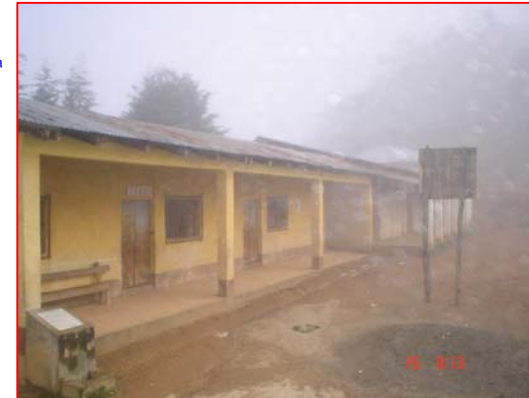
FOTOGRAFIA 1 Módulo de Aulas y Cancha Deportiva.
