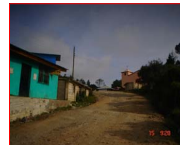
FOTOGRAFIA 3 Pasillo de la escuela, en el cual se observa falta de mantenimiento en la pintura del edificio, así como fugas de agua. Estructura en buen estado.
