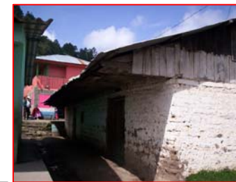
FOTOGRAFIA 3 Módulo de Aulas de Adobe.
