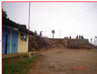
FOTOGRAFÍA 1 Acceso a Escuela y Cancha Deportiva en mal estado, en la plataforma superior se encuentran personal del Ministerio de Salud, en jornada de vacunación, durante el trabajo de campo realizado.
