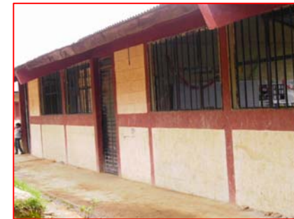
FOTOGRAFIA 2 Módulo de Aulas, se observan muros en buen estado, la estructura portante de techo es de madera y necesita reparaciones, así como la lámina de la cubierta.
