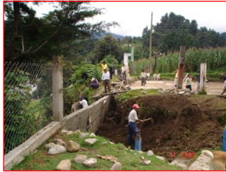
FOTOGRAFIA 2 Trabajos de mitigación en Escuela Primaria
