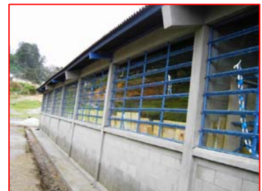
FOTOGRAFIA 5 Ventaneria en buen estado, se observa humedad en la base de los muros, los cuales requieren recubrimiento.
