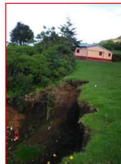
FOTOGRAFIA 5 Deslizamiento de tierra ocurrido para la Tormenta Stan en el 2005.
