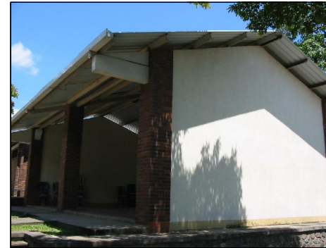
FOTOGRAFIA 1 Como lo muestra en la fotografía, el buen estado de estructura portante y cubierta del edificio, el mantenimiento es el adecuado.
