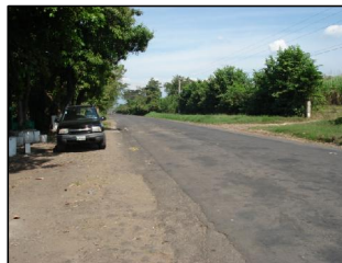
FOTOGRAFIA 2 El exterior del edificio da a calle asfaltada siendo fácil el acceso del edificio.
