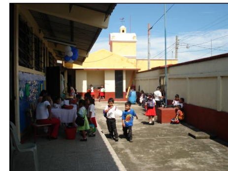
FOTOGRAFIA 3 A pesar de los espacios exteriores reducidos, el mantenimiento se observa el adecuado. Los servicios sanitarios son insuficientes para la cantidad de alumnos que utilizan el establecimiento.
