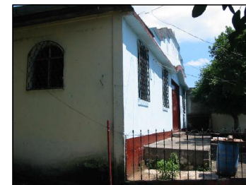
FOTOGRAFIA 5 En la fotografía vemos que el edificio tiene un abito que sirve para no dar directamente hacia la calle, por estar localizado el edificio en el casco urbano.
