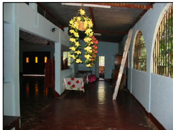
FOTOGRAFIA 2 En esta fotografía, observamos que la ventilación, es adecuada a la edificación.
