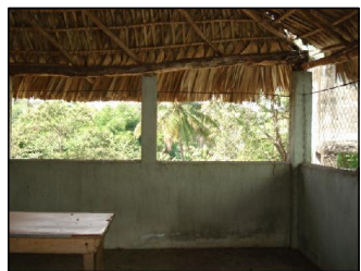
FOTOGRAFIA 4 El cerramiento es a través de muros en buen estado y en los espacios de ventanería malla, para permitir el confort en el interior.
