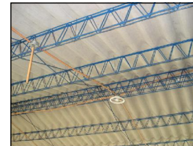
FOTOGRAFIA 7 Vemos el buen estado de la estructura y cubierta del edificio, y la instalación eléctrica semi-oculta.
