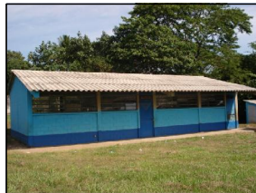
FOTOGRAFIA 1 Se observa el exterior de los edificios con estructura en buen estado, iluminación y ventilación adecuadas.
