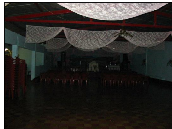
FOTOGRAFIA 4 Se ve el buen estado de la estructura portante del edificio evaluado.
