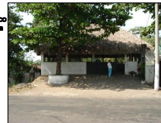
FOTOGRAFIA 3 La salida del edificio da a una área de seguridad para los usuarios del edificio.
