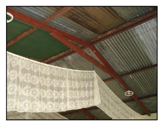
FOTOGRAFIA 5 La estructura del techo se encuentra en buen estado, observamos que la instalación eléctrica es semi oculta.
