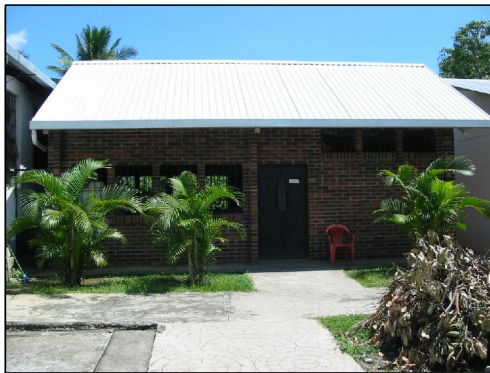
FOTOGRAFIA 2 El exterior de el edificio con jardines permitiendo una evacuación rápida ante una eventualidad.
