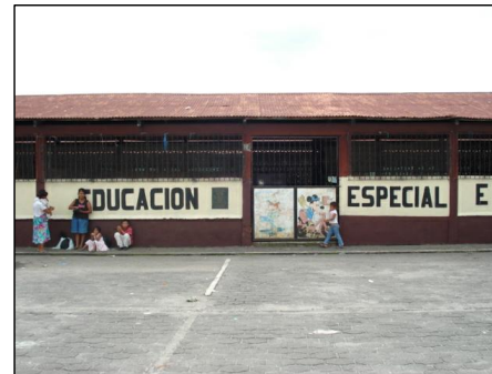
FOTOGRAFIA 3 El entorno del edificio evaluado es adecuado, cuenta con calles asfaltadas, siendo su accesibilidad sin complicaciones.
