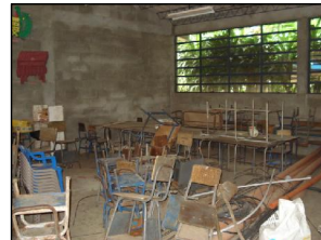
FOTOGRAFIA 4 El cerramiento en cuanto a ventanas, permite una buena iluminación y ventilación.
