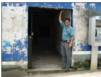
FOTOGRAFIA 1 Como lo muestra en la fotografía, el ingreso principal es demasiado pequeño e inadecuado para evacuar rápidamente el edificio.
