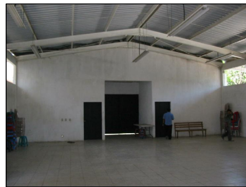
FOTOGRAFIA 3 Muestra la ventilación e iluminación la cual llena los requisitos de confort.
