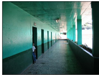
FOTOGRAFIA 1. Se observa pasillos anchos techados, para movilización interna.
