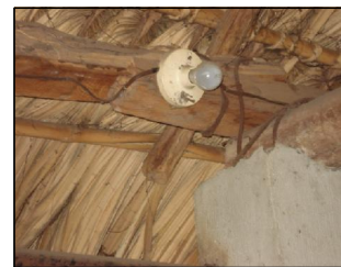
FOTOGRAFIA 5 La instalación eléctrica es vista del edificio.
