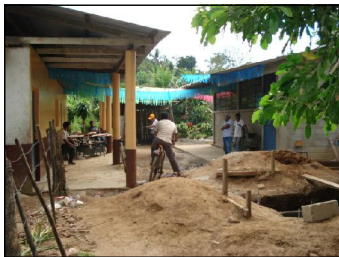
FOTOGRAFIA 6 Como lo muestra en la fotografía, podemos observar la construcción de una Fosa Septica, para para el buen manejo de las aguas servidas de los servicios sanitarios.
