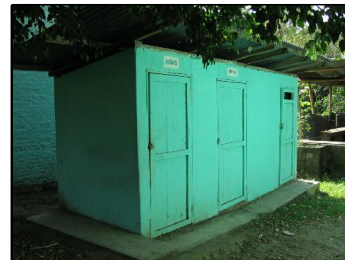
FOTOGRAFIA 6 El exterior del módulo de baños, realma lo expresado en la fotografía 5.
