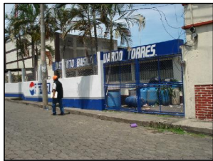
FOTOGRAFIA 1 Indica entrada principal del edificio, Perímetro en buen estado, muestra tanto el primero como el segundo nivel del edificio evaluado. Las calles aledañas se encuentran adoquinadas, cuenta con toda la infraestructura necesaria.
