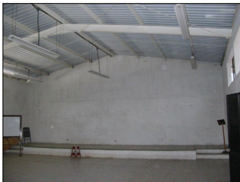
FOTOGRAFIA 2 Se observa el buen estado de la estructura portante del edificio.
