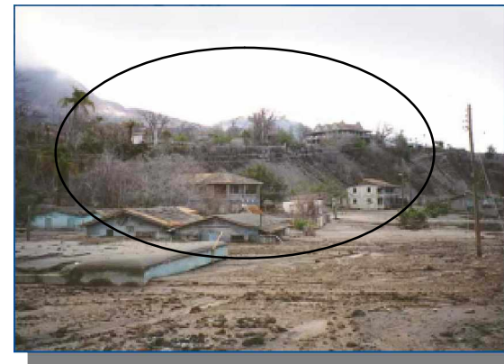
Imagen 07 Destrucciones completas en estructuras
