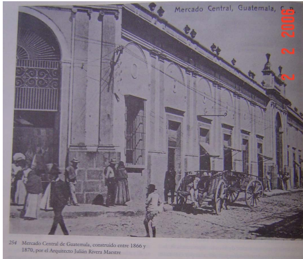
Mercado Central de Guatemala, construido entre 1866 y 1870, por el Arquitecto Julián Rivera Maestre. (1:644)
