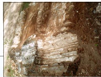
Detalle de Cornisa
