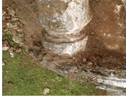
Los rebajes de la base de la columna identificado como D-2
