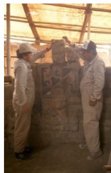
Figura 2: Reposición del muro oeste del recinto 8.
