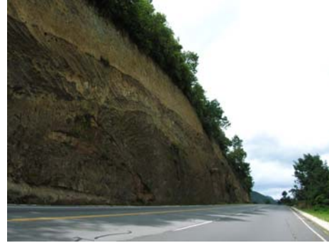
Corte de talud, kilómetro 166, agosto de 2006
