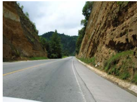
Corte de material de forma vertical, sin la utilización de plataforma, movimiento de material hacia otro lugar, julio 2006
