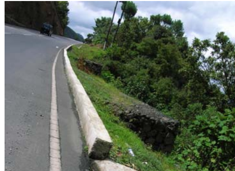
Muro de contención tipo gavión con malla acerada, kilómetro 184, julio 2006
