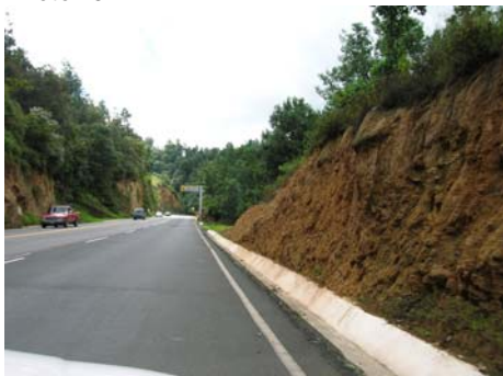
Corte de material que fue trasladado para otro espacio, debido a la topografía irregular del área, julio 2006
