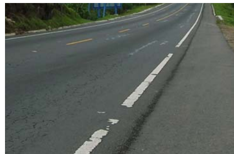
Kilómetro 173 parte recta de la carretera donde se aprecia la línea punteada que indica que es posible rebasar, julio 2006
