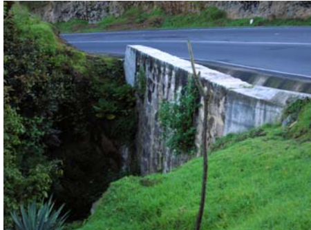
Muro de contención de concreto reforzado, kilómetro 183, julio 2006
