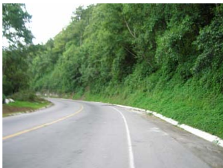
Revestimiento natural de maleza endémica que se manifiesta con mayor riqueza en época de invierno. Kilómetro 174 agosto 2006
