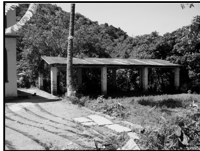
Fotografía No. 9 salón de usos múltiples. Finca La Florida.
