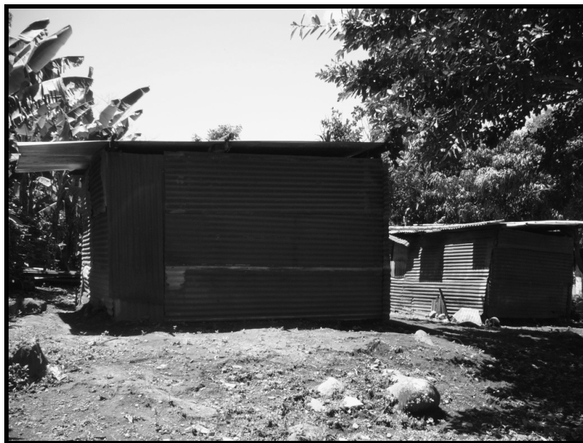
Fotografía No. 16 viviendas tipo 4.
