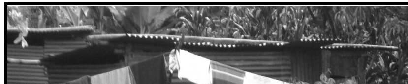
Fotografía No. 30: cubierta en vivienda tipo 1
