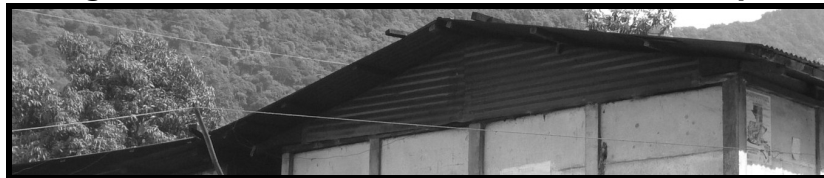
Techo a dos aguas
