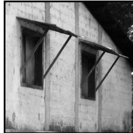
Fotografía No. 45: ventanas en vivienda tipo 4
