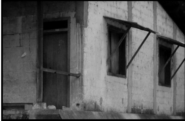
Fotografía No. 46: muros en vivienda tipo 4
