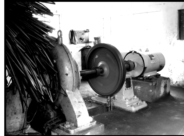
Fotografía No. 19: Generador Diesel
