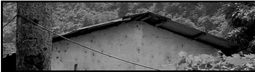
Fotografía No.47: cubierta en vivienda tipo 4
