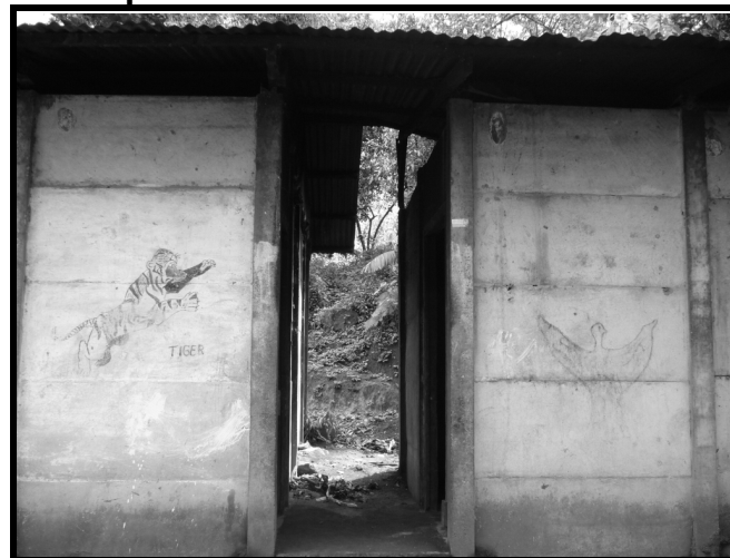
Fotografía No. 53: corredor de acceso en vivienda tipo 5
