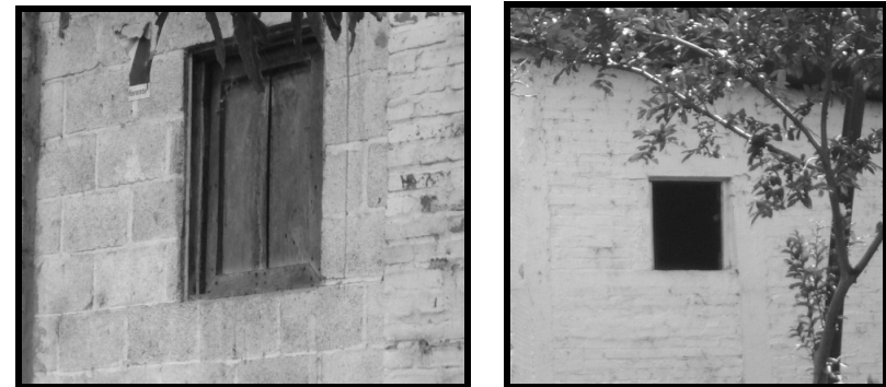
Fotografía No. 34: ventanas en vivienda tipo 2
