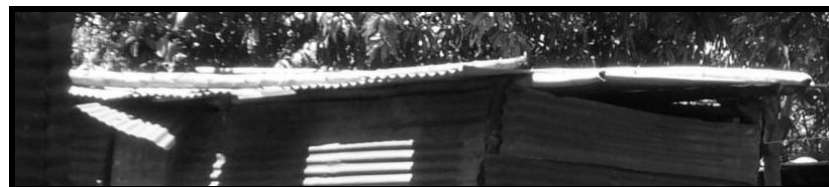
Fotografía No. 29: cubierta en vivienda tipo 1
