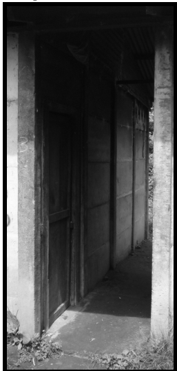
Fotografía No. 50: puertas vivienda tipo 5
