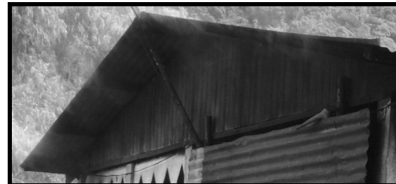
Fotografía No. 40: cubierta en vivienda tipo 3
