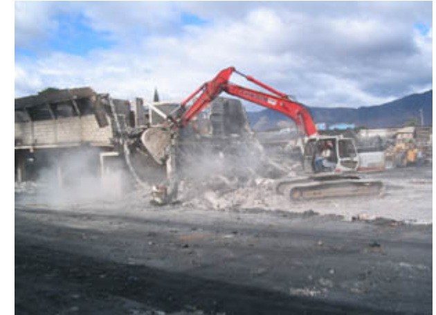
Fotografía 3: aquí la maquinaria esta demoliendo las antiguas instalaciones del mercado que aquí se encontraba.
