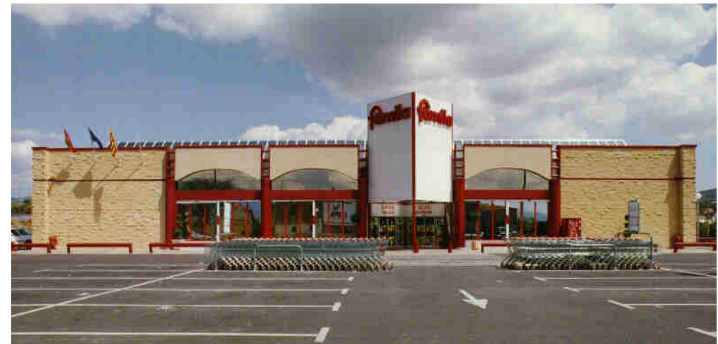
Imagen No 3 - Centro Comercial Familia México D.F. – (Materiales usados: Block visto, metal, lámina, vidrio)
