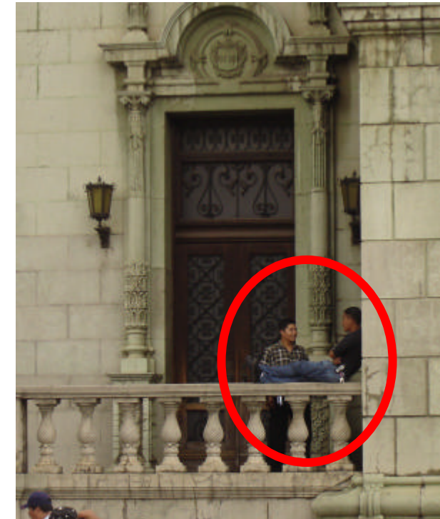
Foto No. 32 Destrucción de las instalaciones del Palacio Nacional de la Cultura por falta de Educación a la población. Fotografía: Luisa Fernanda Santoveña Perussina
