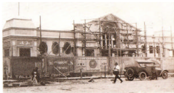
Foto No. 7. Palacio del Centenario (en construcción)
