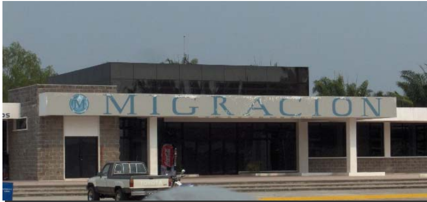
F-11: Fachada del Edificio de Migración del Paso Fronterizo Ing. Juan Luis Lizarralde Arriaga, frontera con México
