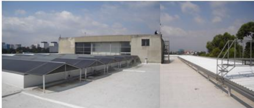
VISTAS DEL TECHO
