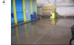
AREA DE BAÑOS
