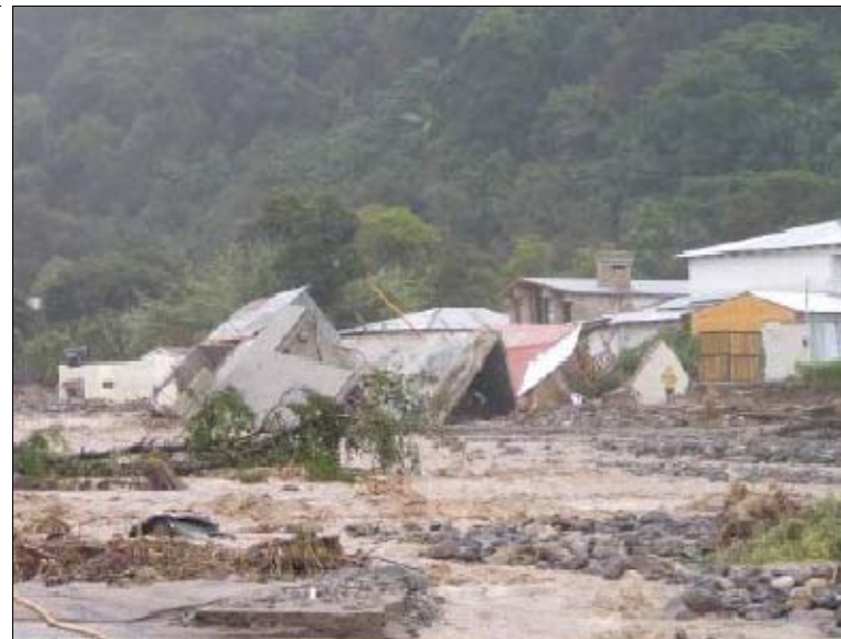
VIVIENDAS DESTRUIDAS POR RÍO SAN FRANCISCO.
