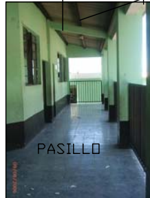
VISTA DE PASILLO DE TERCER NIVEL
