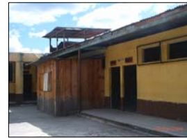
VISTA DE SERVICIOS SANITARIOS
