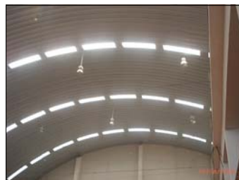
ESTRUCTURA DE TECHO CON EMCO
