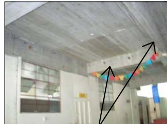
ESTRUCTURA CON VIGAS
