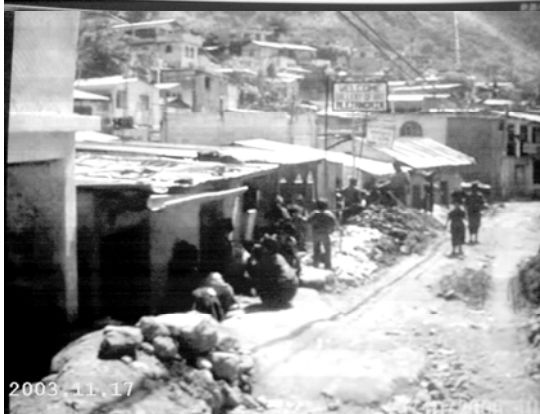
Calles completamente dañadas 1
