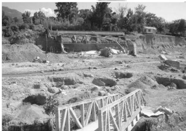
Planta de Tratamiento y puentes peatonales destruidos Fuente: Nancy Martínez.
