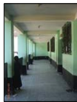
VISTA PASILLO SEGUNDO NIVEL
