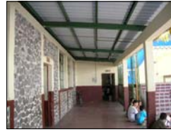
ESTRUCTURA METALICA CON COSTANERAS CUBIERTA DE HIERRO.
