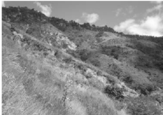
Deslizamiento generado por la saturación de agua en el suelo arenoso, la deforestación y porcentaje de Pendiente. Fuente: Vivamos Mejor.
