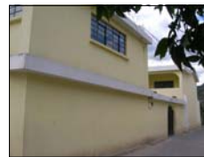
Vista Frontal Vista de 1ra Calle
