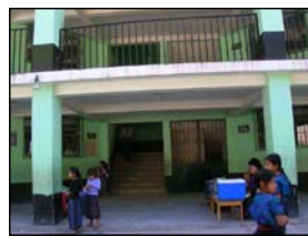
VISTA DE MODULO DE GRADAS
