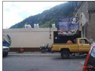
VISTA HACIA INGRESO
