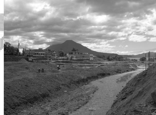
Trabajos de dragado de río.
