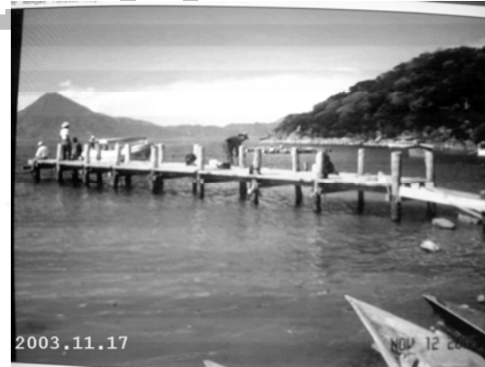
Muelles en Construcción 1
