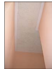
Acabado de Techo con Cerrino Rustico
