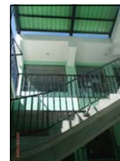
VISTA DE MODULO DE GRADAS
