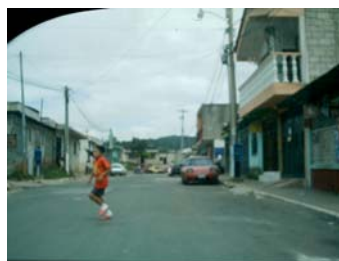
Imágenes 52 y 53 Vista hacia Colonia Lomas de Santa Faz, donde se puede observar la tendencia del terreno en laderas. A la derecha una de las calles de la colonia Lomas de Santa Faz. Se pueden ver viviendas sencillas y casas de dos o tres niveles de mampostería. Fuente: Débora Moctezuma. Visita de campo. Octubre 2006.
