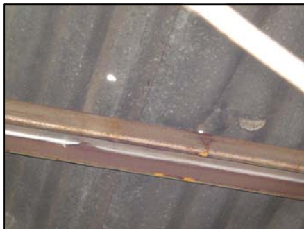
FOTOGRAFIA 4 puede notarse las costaneras invertidas (mal colocadas) y su grado de oxidación, además la lámina presenta agujeros, los cuales son goteras en invierno. Hay varias láminas dañadas también por oxido.
