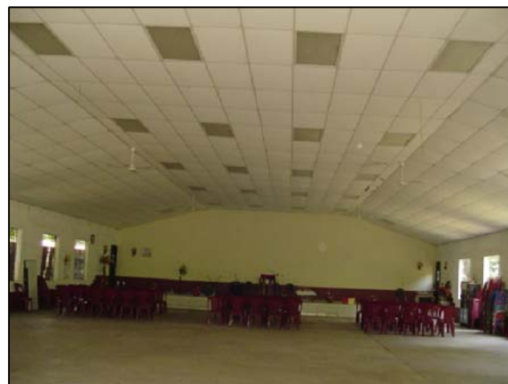
FOTOGRAFIA 5 Vista interna de la Iglesia, la cual en la cual se puede observar el cielo falso y sus lámparas de 4'40 T12, con difusor prismático, el ambiente interno es mas bajo que el externo debido a los materiales y lo ventilado del lugar por las ventanas laterales las cuales no poseen vidrio.
