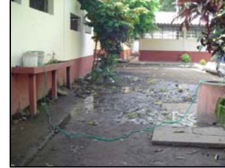
FOTOGRAFIA 6 como en la mayor parte del municipio, El Obrero también no cuenta con servicios de drenaje por lo que este tema se vuelve un foco crítico y de riesgo para la salud del estudiante o el posible refugiado.
