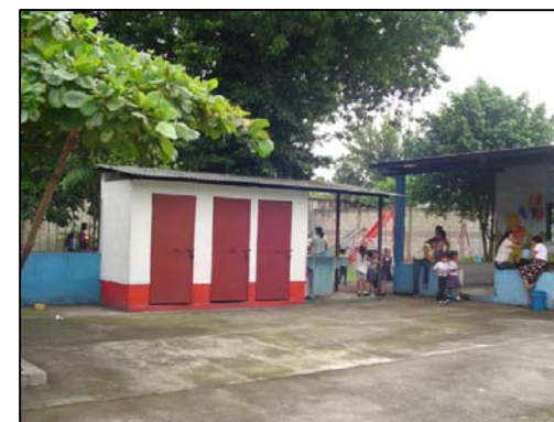
FOTOGRAFIA 3 Vista frontal desde el patio, hacia los servicios sanitarios, solo se posee uno por sexo y uno para maestros. Esta servicio, divide el patio con el área de juegos.
