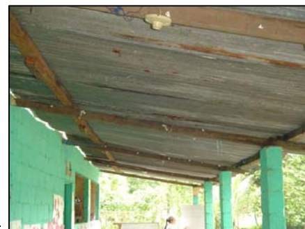
FOTOGRAFIA 4 puede notarse las costaneras invertidas (mal colocadas) y su grado de oxidación, además la lámina presenta agujeros, los cuales son goteras en invierno. Hay varias láminas dañadas también por oxido.
