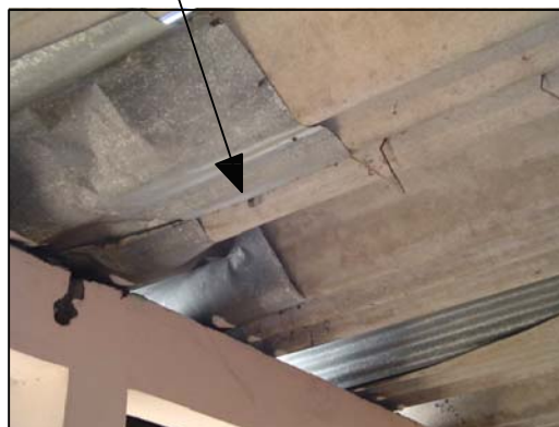
FOTOGRAFIA 5 Las láminas de asbesto en su mayoría ya presentan daños como fisuras, partes quebradas que han sido objeto de colocar otras metálicas para evitar la filtración del agua al interior de aulas.
