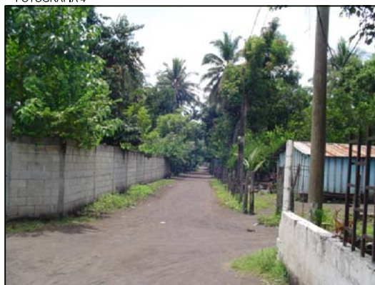
los caminos secundarios son de tierra y no cuentan con banquetas, señalización y la iluminación artificial es espaciada.
