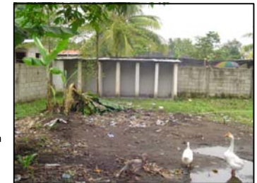
FOTOGRAFIA 2 Cuenta con una pila de servicios sanitarios en remodelación que aún no estan habilitados.
