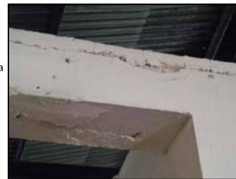
FOTOGRAFIA 5 las fundiciones de vigas entre construcción nueva vs. antigua, dejan notar la deficiencia de las mismas
