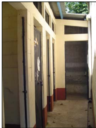
FOTOGRAFIA 4 Los servicios sanitarios son de loza sanitaria, por lo que su primer aspecto es de un mantenimiento periódico.
