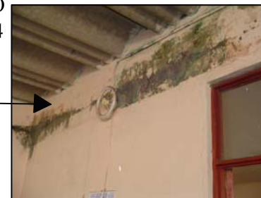
FOTOGRAFIA 1 Humedad en las paredes debido al mal estado del techo.
