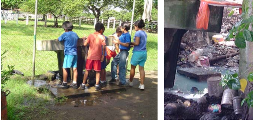
Fotografía No. 15: Aguas pluviales y servidas sin control
