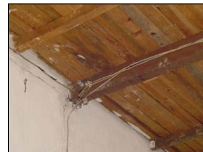
FOTOGRAFIA 2 Las instalaciones eléctricas son expuestas, y el área de administración tiene cielo falso de madera.
