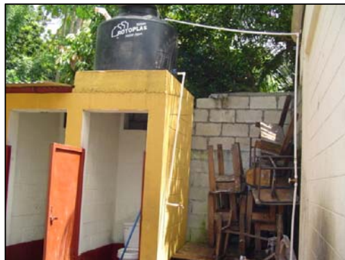
FOTOGRAFIA 4 Cuenta con área de servicios sanitarios y con un tanque elevado el que abastece de agua potable.
