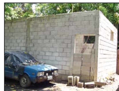
FOTOGRAFIA 2 Vistas externa de los servicios sanitarios los cuales se encuentran en fase de construcción, debido a que la obra es recientemente nueva, contará con 4 servicios cada baño.
