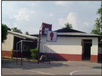
FOTOGRAFIA 1 Las aulas de la escuela, son independientes unas con otras en su mayoría de construcción, notando un aporte de entidades en la construcción de aulas, pero también dejando notar ampliaciones no planificadas
