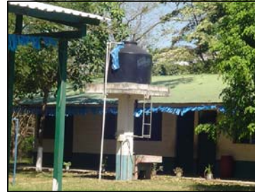
FOTOGRAFIA 4 cuenta con un cisterna alto, llenado por bomba desde el pozo, pero no cuenta con un sistema de filtración,
