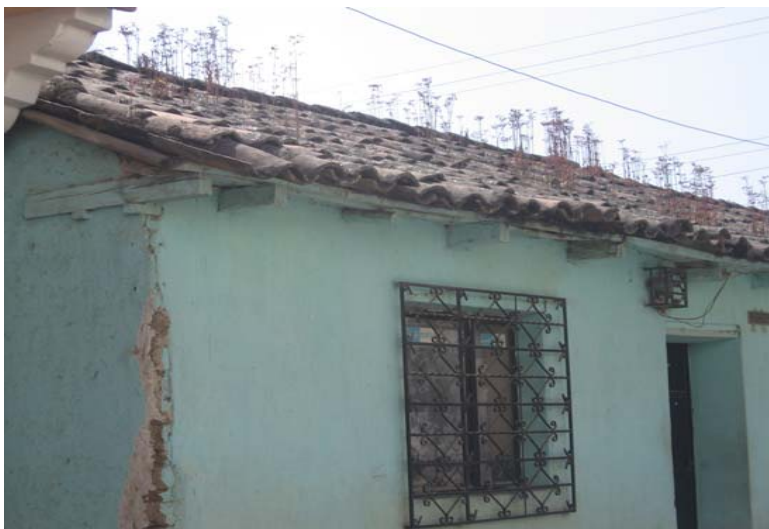
Foto No. 31 cubierta de vivienda sector A
