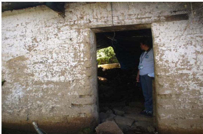
Foto 45 Aspecto físico-estructural de viviendas.
