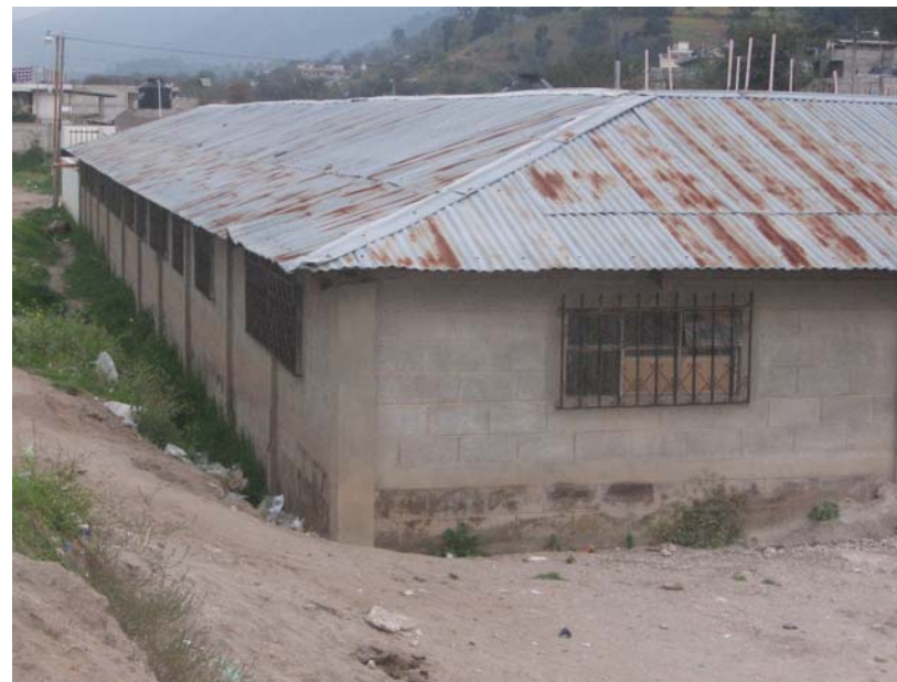
Foto 27 Fotografía actual de la escuela primaria del municipio de Olintepeque.
