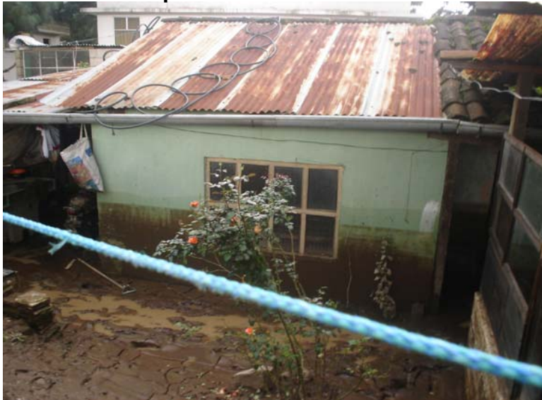
Foto 44 Aspecto físico-estructural viviendas
