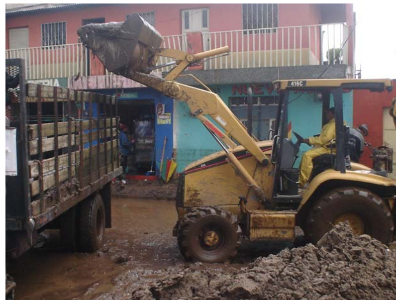
Foto 25 Reconstrucción de vías de acceso principales al municipio.
