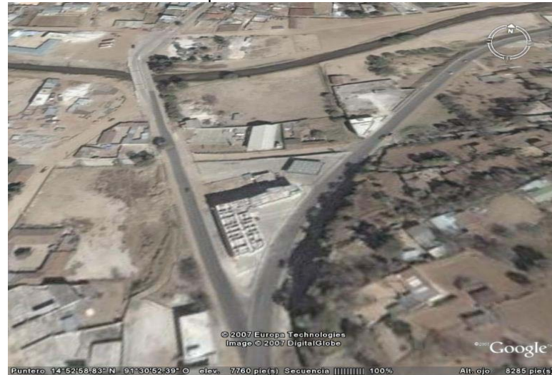
Foto 12 Puente de ingreso a municipio
