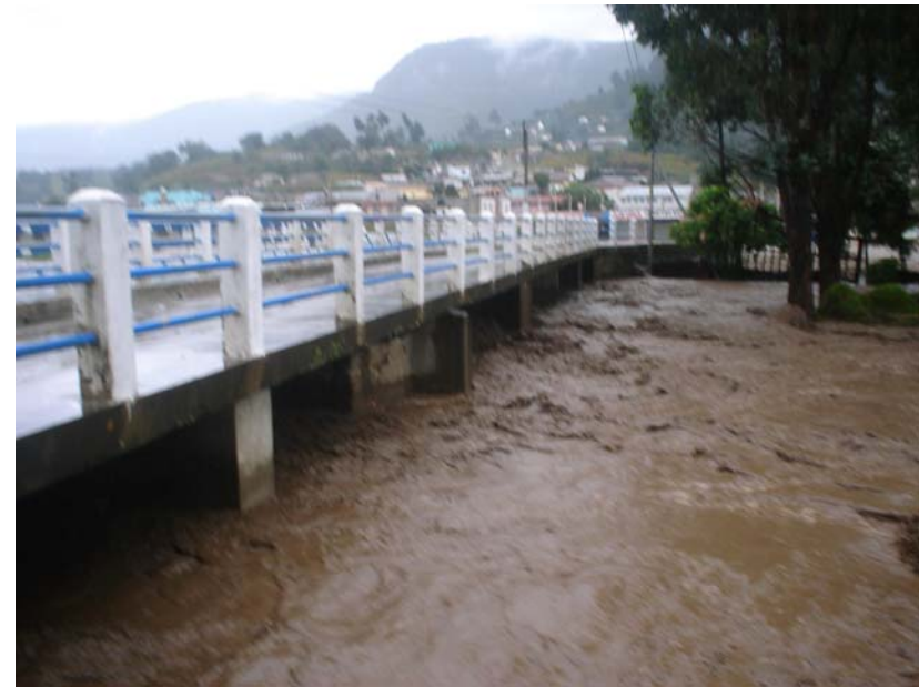
Foto 49 Estructura de las vías de acceso sector D
