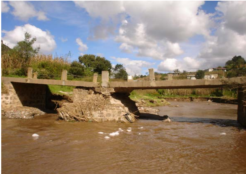
Foto 50 Estructura de las vías de acceso sector D
