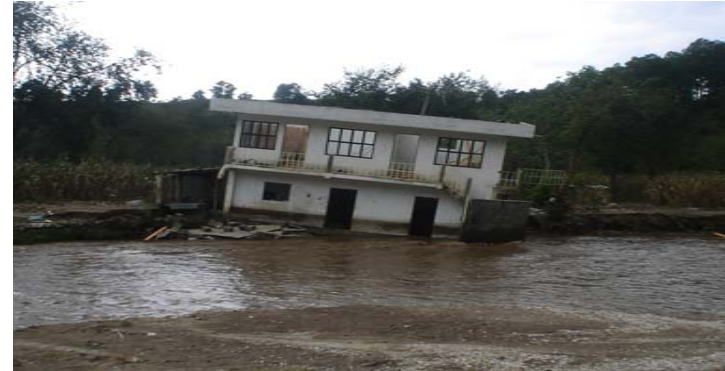
Foto 16 Ubicada en el sector C
