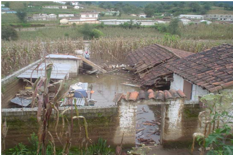
Foto 47 Estructura de la vivienda sector D
