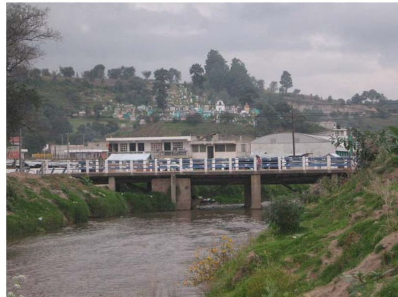
Foto 38 Fuente Elaboración Propia Visita de campo
