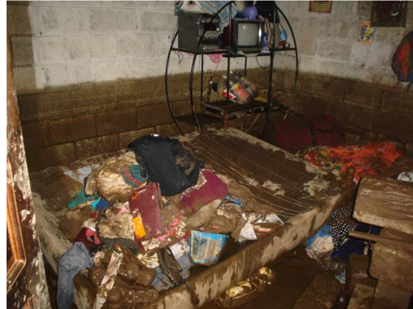
Foto 9 Vivienda afecta ubicada en el sector D.
