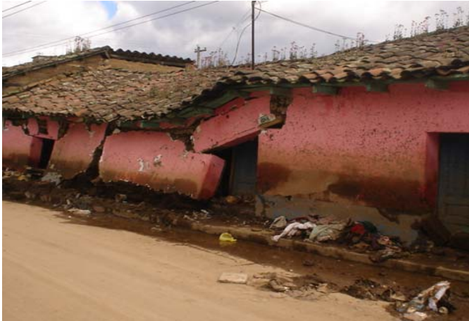
Foto 15 Ubicada en el sector C
