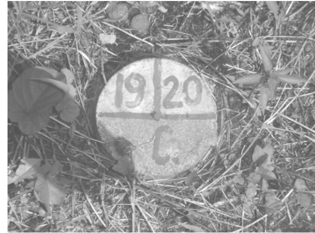
Los lotes de la primera fase se encuentran amojonados. Calles trazadas y actualmente con capa de balastro
