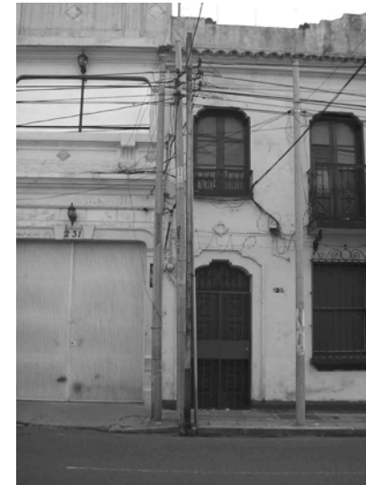
Foto No. 23 Los postes de telefonía son más delgados que los de electricidad, pero a veces están colocados en grupos de tres. Toma: Ana C. Quiñónez J.
