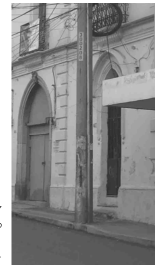
Foto No. 17 Las aceras están invadidas por postes o mobiliario urbano lo que impide que los peatones transiten cómodamente. Toma: Ana C. Quiñónez J.
