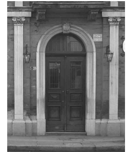
Foto No. 3 Puerta de ingreso de uno de los inmuebles categoría "B", en donde se puede observar la sobriedad del estilo Neoclásico. Toma: Ana C. Quiñónez J.
