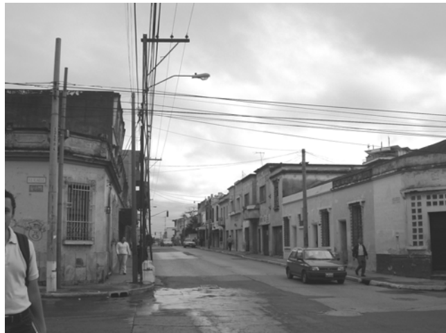
Foto No.22 El paisaje urbano de la 12 Calle luce saturado de postes de electricidad con transformadores, con alumbrado público o de alta tensión. Toma: Ana C. Quiñónez J.
