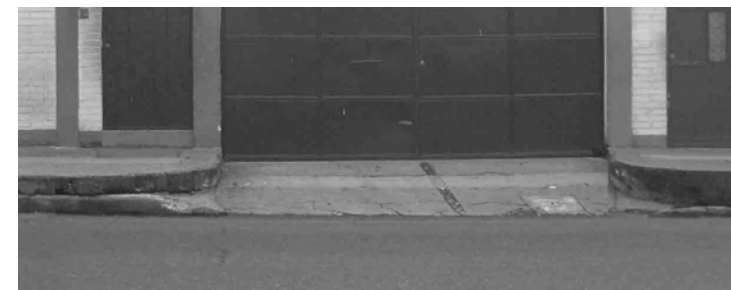
Foto No. 18 En las aceras existen cambios de nivel muy bruscos y sin ningún tipo de aviso para personas discapacitadas. Toma: Ana C. Quiñónez J.
