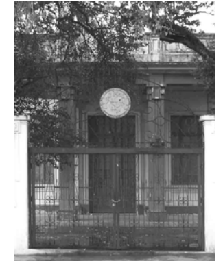
Foto No. 2 Pórtico de ingreso en el edificio de la antigua Facultad de Odontología. Toma: Ana C. Quiñónez J.
