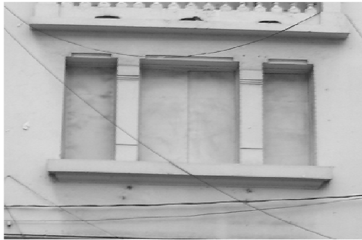
FOTOGRAFÍA No. 19 NÓTESE QUE LOS VANOS DE ESTA VENTANA HAN SIDO TAPIADOS
