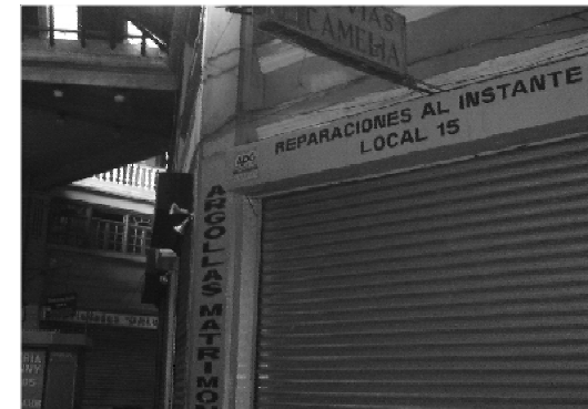
FOTOGRAFÍA No. 42 NÓTESE EL USO DE PINTURA DE ACEITE EN ESTE LOCAL
