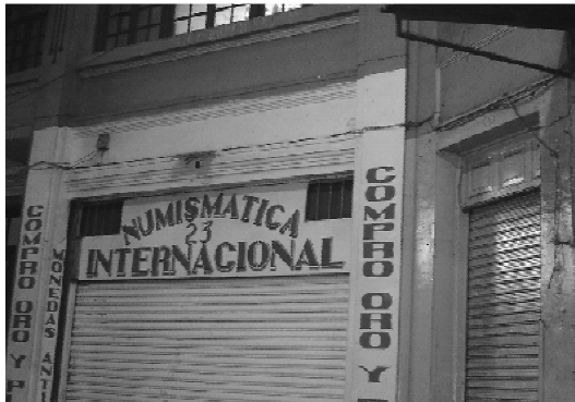
FOTOGRAFÍA No. 37 NÓTESE EL USO DE PINTURA DE ACEITE PARA LOS MUROS DE ESTE LOCAL Y LAS INSTALACIONES ELÉCTRICAS QUE VAN EXPUESTAS A LO LARGO DEL PASAJE CENTRAL
