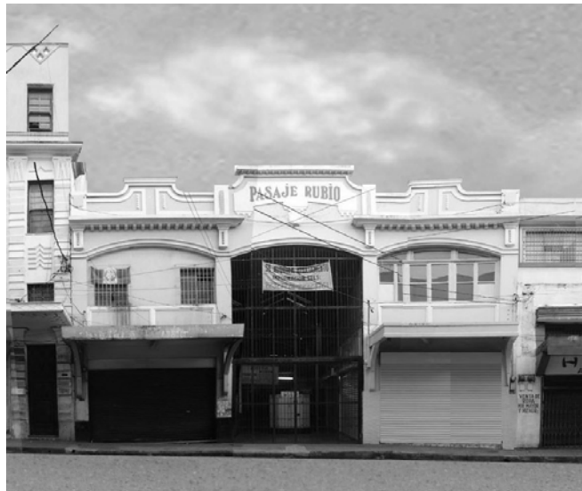
Foto No. 17 Fachada Pasaje Rubio Novena Calle Fuente: Fotografía tomada por autor.
