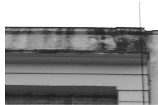
FOTOGRAFÍA No. 3 SE APRECIA LA EXISTENCIA DE HUMEDAD EN EL REMATE DE LA FACHADA DE LA SEXTA AVENIDA
