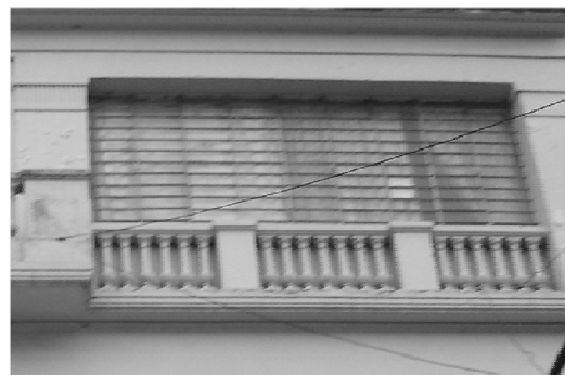
FOTOGRAFÍA No. 23 NÓTESE QUE LA VENTANERÍA ORIGINAL HA SIDO REMPLAZADA POR UNA DE CORTE MODERNO
