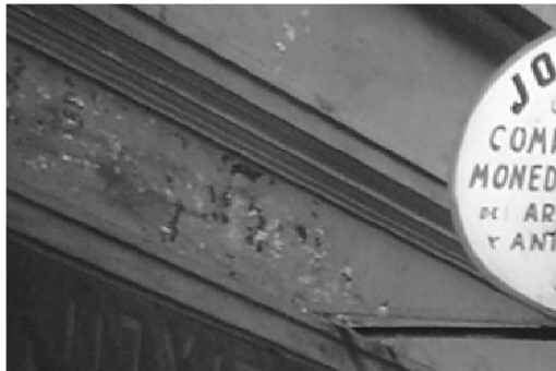
FOTOGRAFÍA No. 13 NÓTESE LA SUCIEDAD QUE PRESENTA ESTA PARTE DEL MURO DEL PASAJE
