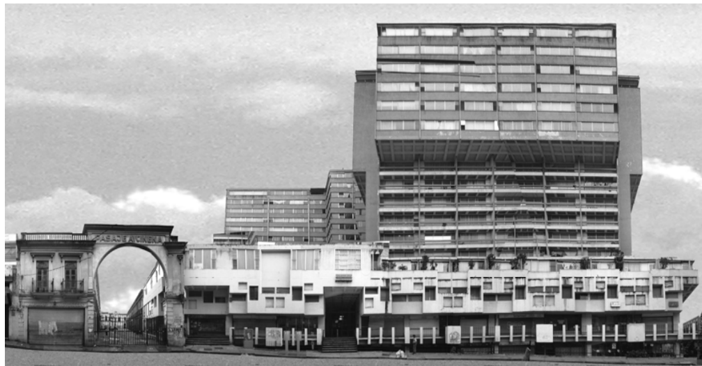
Foto No. 4 Pasaje Aycinena y edificio El Centro Fuente: Fotografía tomada por autor
