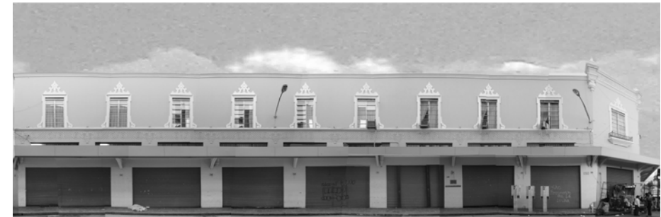
Foto No. 7 Edificio Empresa Eléctrica Fuente: Fotografía tomada por autor
