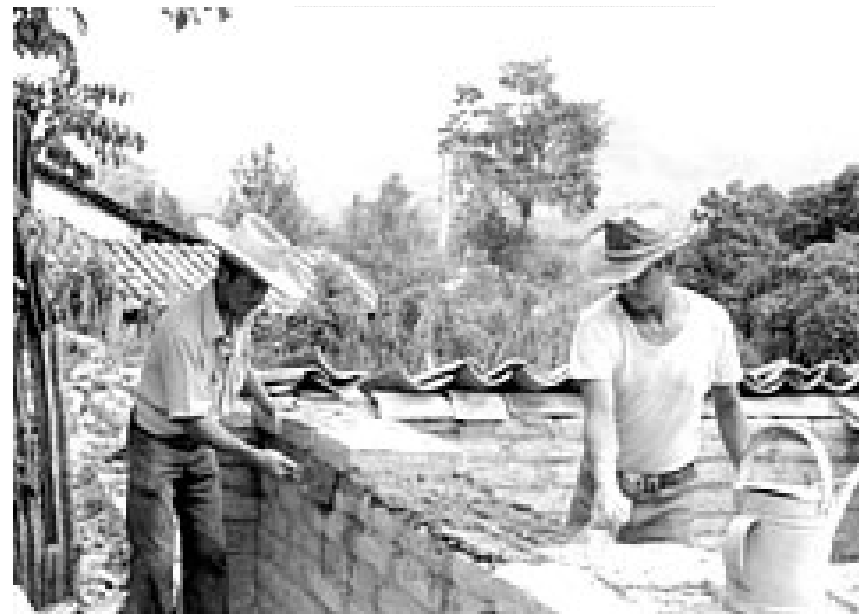
Foto No.7 Construcción en adobe Fuente: Ejemplo tomado de internet
