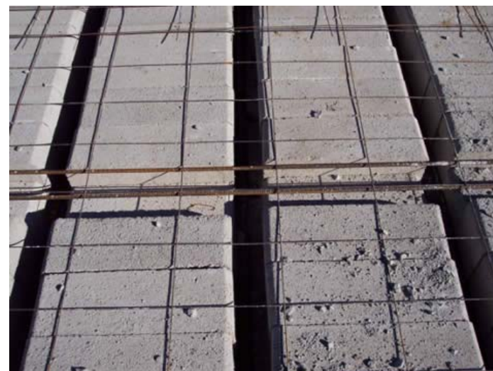
Foto No.11 Prefabricados en Concreto Fuente: Edición Propia
