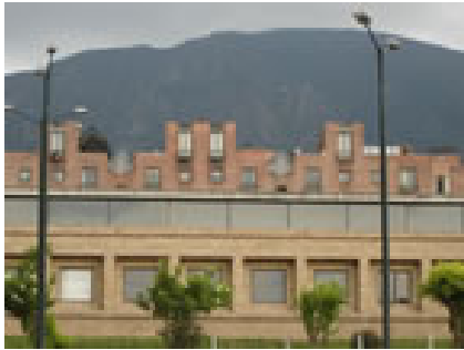
20. Equipamiento Urbano (Salón Comunal)
