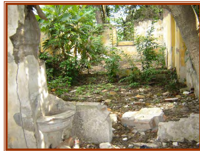
Finca Las Margaritas, aún se aprecian los muros de ladrillo y piedra, con algunas pequeñas pilas y tomas de agua. Foto: DafneE
