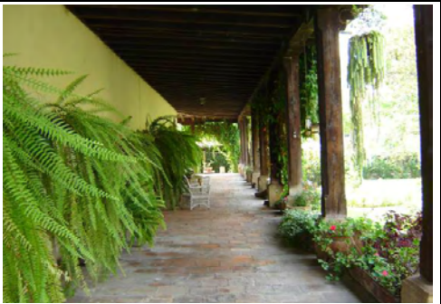
PASILLO DE LA CASA PATRONAL Piso de baldosas de barro, bases de columna de piedra tallada y fustes de madera.
