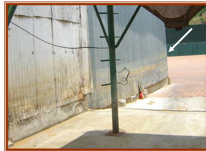
Seña de la inundación del desbordamiento del río Guacalate durante la tormenta Stan en 2005 en finca Pastores, llegó a más de 2m sobre el nivel de los patios de secado. Foto: DafneE
