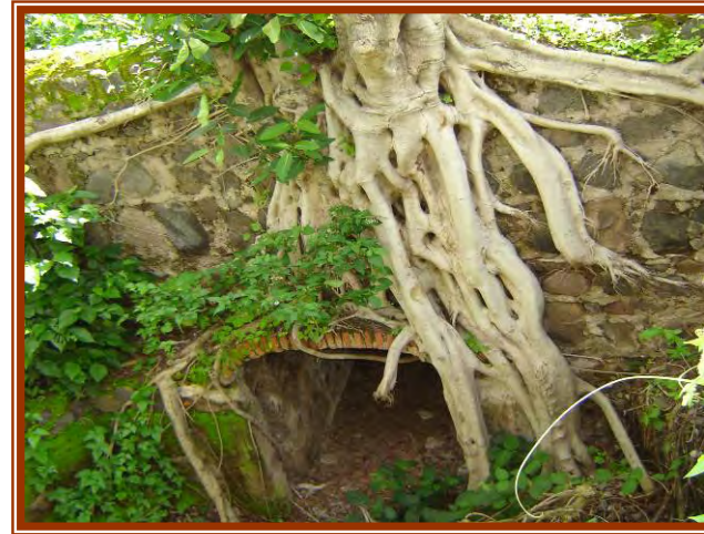
Ruinas de acueductos, totalmente invadida por raíces y abundante vegetación, San Rafael Urías. Foto: DafneE
