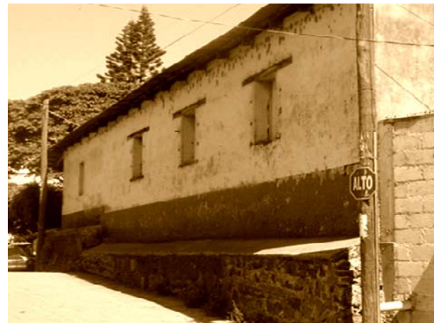
FOTOGRAFÍA No. 29. EDIFICIO MUNICIPAL DE SAN LUCAS TOLIMÁN. Vista de fachada sur, contrafuerte corrido de piedra de cantera.
