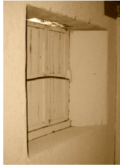
FOTOGRAFÍA No. 27. EDIFICIO MUNICIPAL DE SAN LUCAS TOLIMÁN. Vista de ventana desde el interior del salón municipal.
