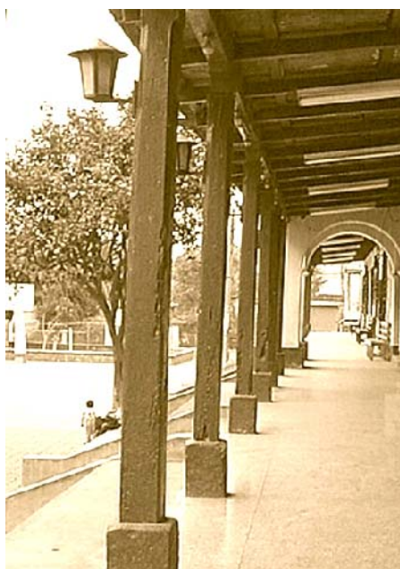
FOTOGRAFÍA No. 22 Y 23. EDIFICIO MUNICIPAL DE SAN LUCAS TOLIMÁN. Diferentes vistas del corredor principal.
