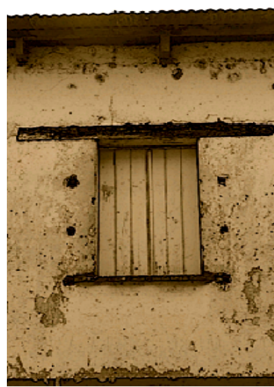
FOTOGRAFÍA No. 28. EDIFICIO MUNICIPAL DE SAN LUCAS TOLIMÁN. Vista de ventana desde el exterior en la fachada sur del edificio.
