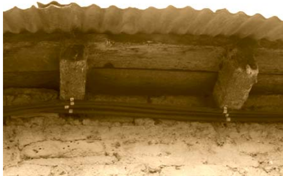
FOTOGRAFÍA No. 34. EDIFICIO MUNICIPAL DE SAN LUCAS TOLIMÁN. Vista de elementos estructurales horizontales (canes).
