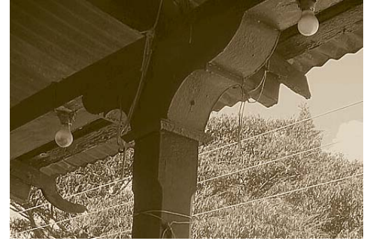
VISTA DE ZAPATA
