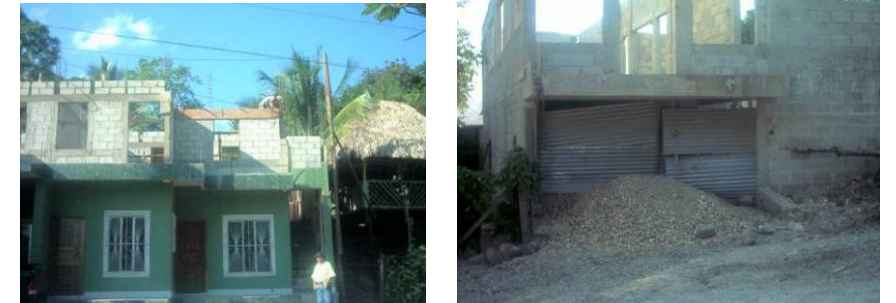
Fotos 3 Y 4 de viviendas típicas en aldea Fronteras, Río Dulce, material comúnmente utilizado en e área urbana es de mampostería reforzada.
