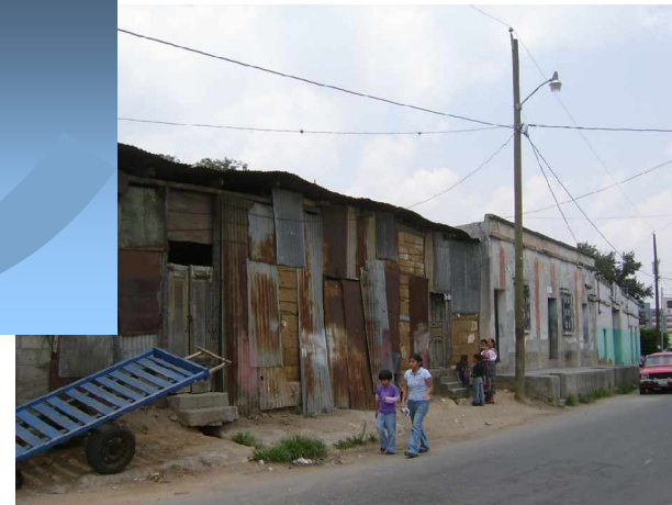
Estado actual 30 Avenida y 30 Avenida B.
