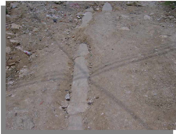
Existencia de drenajes en el sector
