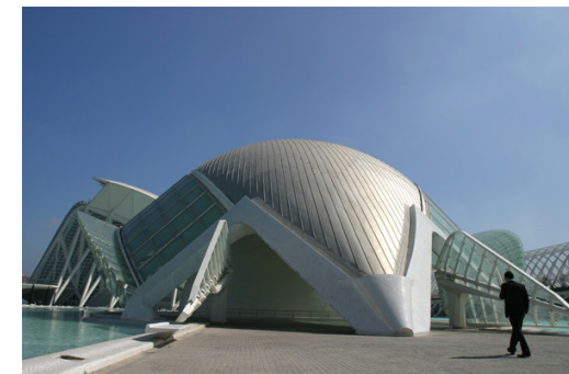
Foto 7.2 El Planetario: Es edificio de planta elíptica, sostenida por arcos perimetrales inclinados, y partes metálicas móviles la cual envuelve una sala hemisférica de hormigón
