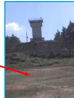
Esta fotografía muestra parte del perímetro del solar Fuente: Sistema Penitenciario
