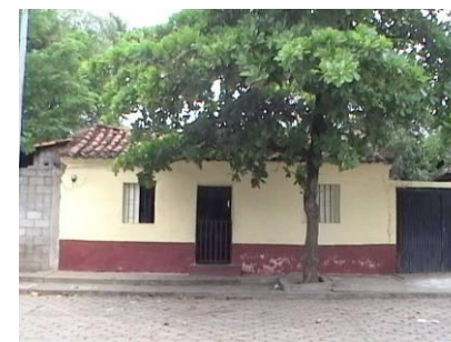
Fotografía 63. Vivienda Unifamiliar ubicada sobre la Vía 5 de la Zona 1 Barrio Centro. Fuente: Elaboración propia
