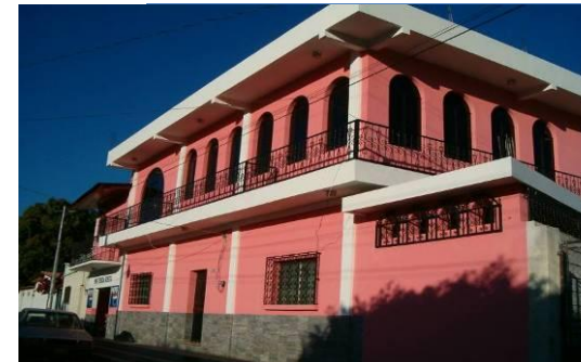
Fotografía 34. Vivienda de dos niveles con losa de concreto, y marquesinas salientes. Fuente: Elaboración propia
