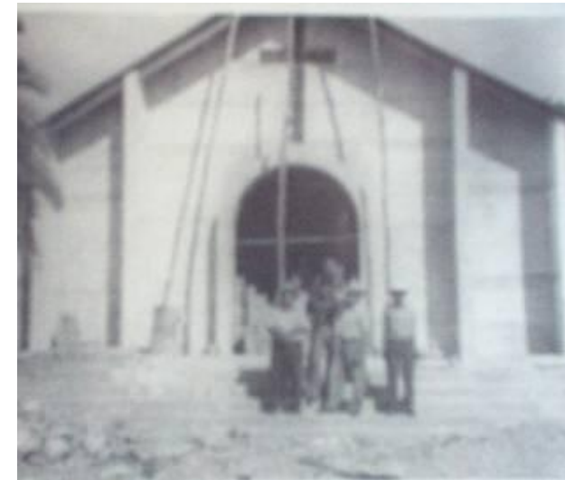
Fotografía 87. Construcción de la nueva iglesia, después del terremoto de 1976.
