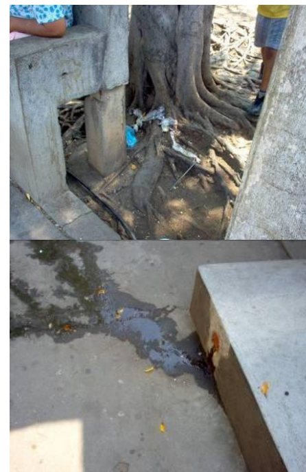
Fotografía 78. Varios árboles no están bien cuidados y por consiguiente se secan. Además existen drenajes pluviales y basura a la intemperie.
