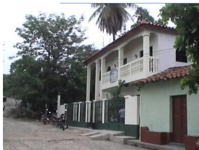
Fotografía 56. Edificio de Registro de Información Catastral ubicado sobre la 5ta. Calle 1-39 de la Zona 1 Barrio Centro.
