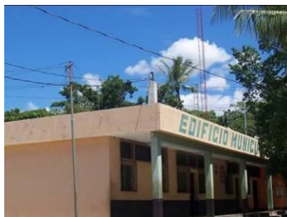
Fotografía 54. Edificio Municipal ubicado sobre la Vía 5 de la Zona 1 Barrio Centro.
