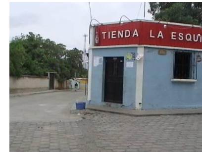
Fotografía 70. Tienda sobre la 3ra. calle Barrio Centro. Fuente: Elaboración propia
