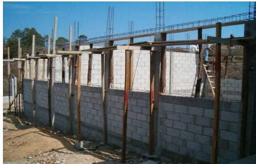
Fotografía 31. Vivienda en construcción a base de block Fuente: Elaboración propia
