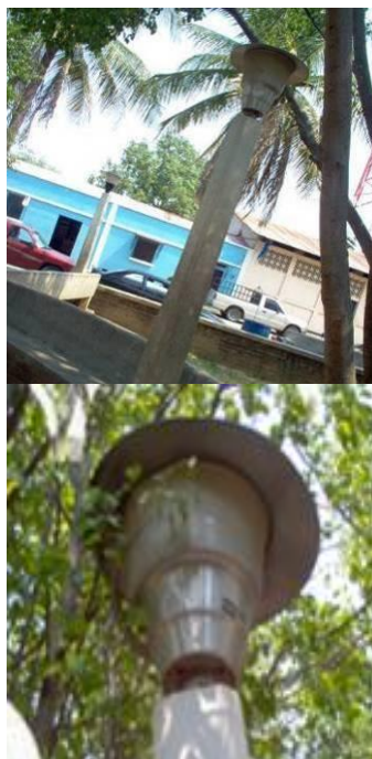
Fotografía 85. El parque pose deficiente iluminación, y las luminarias están descuidadas.
