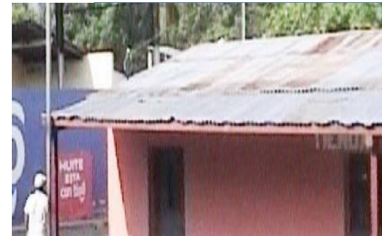
Fotografía 35. Vivienda-Comercio con cubierta de lámina de zinc Fuente: Elaboración propia
