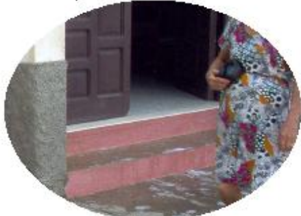
ALTERACIÓN ESPACIAL por grietas en la banqueta y no tener arbo
