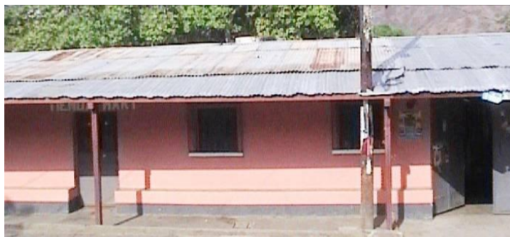
Fotografía 42. Vivienda típica de la región a base de muros de block y techo de lámina Fuente: Elaboración propia
