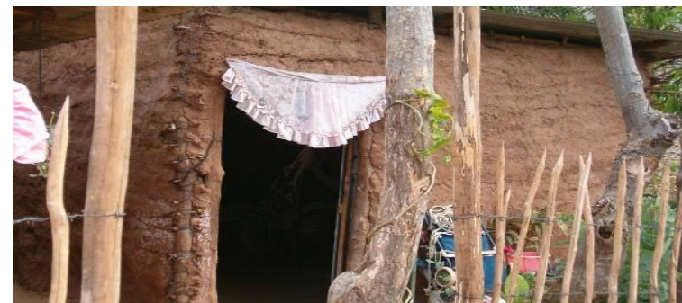
Fotografía 51. Vivienda vernácula, con muros de adobe Fuente: Elaboración propia
