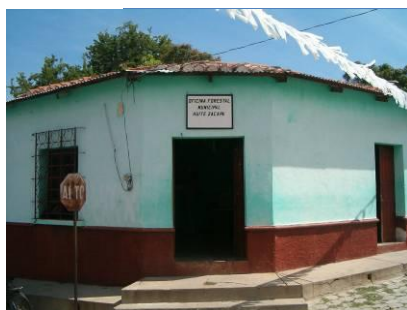
Fotografía 55. Edificio Forestal Municipal ubicado sobre la Vía 4 de la Zona 1 Barrio Centro.
