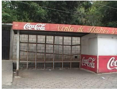
Fotografía 67. Caseta sobre la Vía 5 Barrio Centro. Fuente: Elaboración propia
