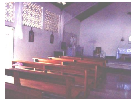
Fotografía 90. Escasez de luz y ventilación, debido a esto hay demasiado calor lo que afecta el confort de los visitantes. Fuente: Elaboración propia
