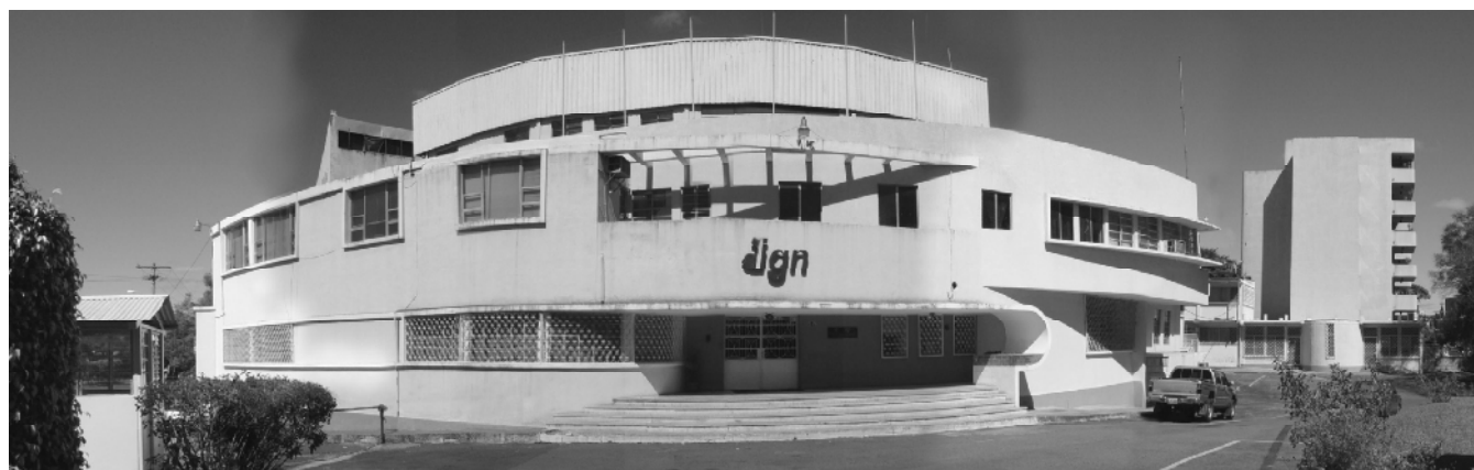
Panorámica de la fachada del edificio del Instituto Geográfico Nacional, Ing. Alfredo Obiols Gómez, fotografía diciembre 2006
