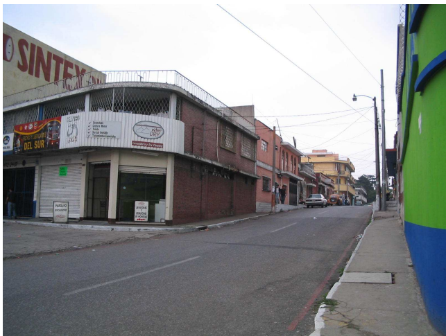
Fotografía No.21 Vista del deterioro del tratamiento de fachadas.
