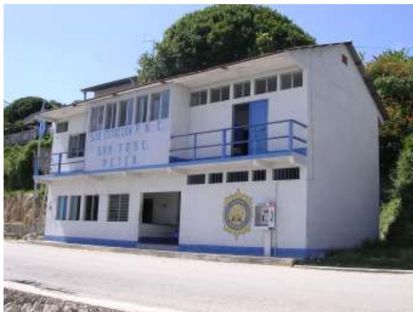
Edificio de la Policía Nacional Civil. Fotografía No.17 (ver localización mapa No.8)
