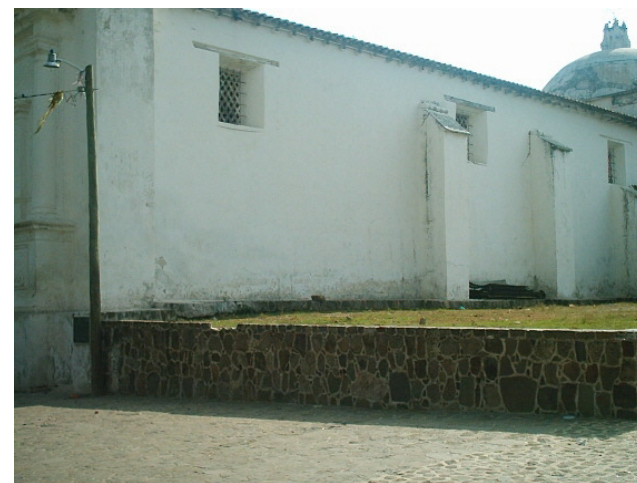
VISTA EXTERIOR DEL MURO, CONTRAFUERTES, VENTANAS Y TIPOS DE CUBIERTA (ARTESONADO Y CÚPULA)
