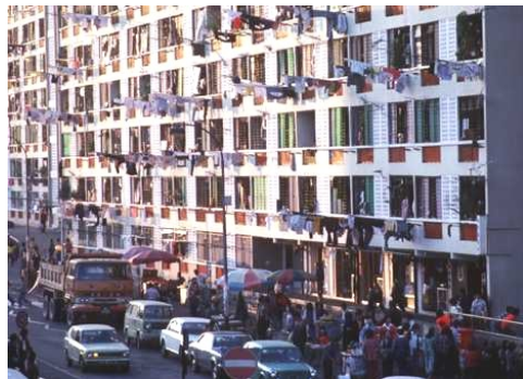
Módulos Habitacionales (Condominios) en Hong Kong
