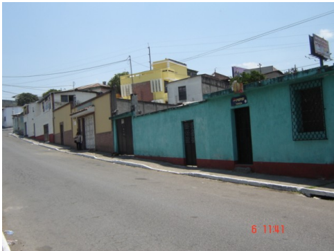
Av. el Mariscal, entre 5ta. calle y 6ta. Calle (No. 12)
