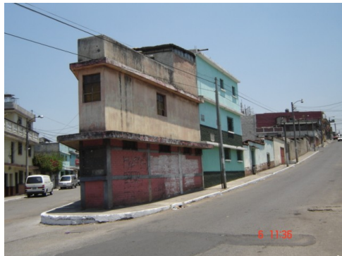
Av. el Mariscal, entre 6ta. calle y 5ta. Calle (No. 14)
