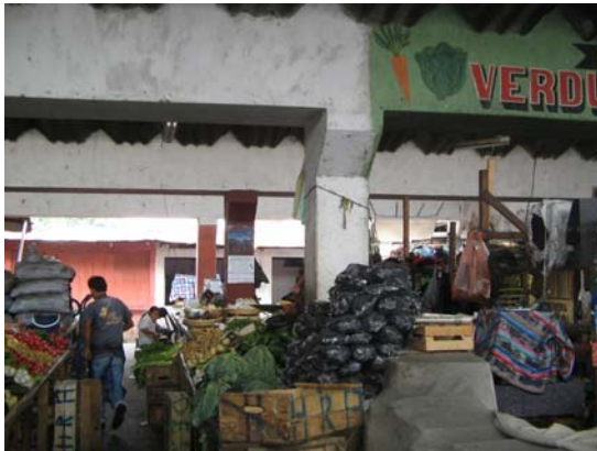
Fotografía No.12 Lámina de Asbesto Cemento
