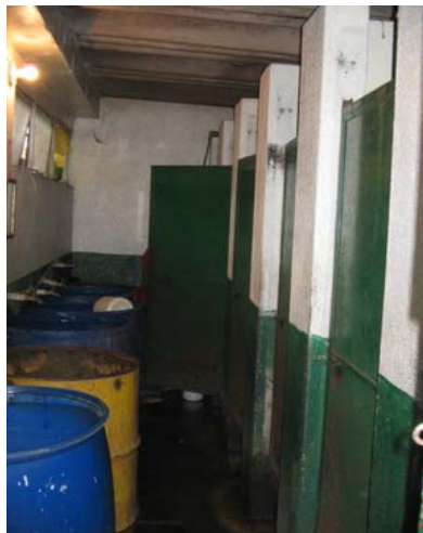
Fotografía No.9 Servicios Sanitarios
